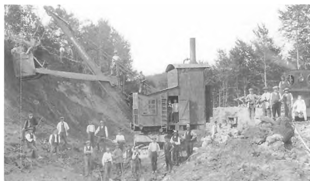
Jordlag med glideler gav store problemer ved anlæggelsen af banetracèet i Marielundsskoven. Dampdrevet gravko var en stor arbejdslettelse.
