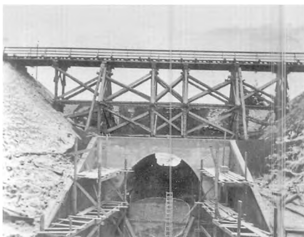
Øverst interimsbroen, som Egtvedtoget kørte på under hele arbejdet. I midten kromandens bro, og nederst er støbearbejdet til den 26 m. lange tunnel ved at være færdigt. Gitterdragerne blev siddende i retableringen af dæmningen.
