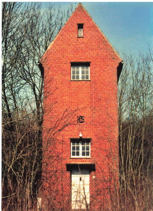
Denne transformatorstation står ved Fynsvej. Bogstaverne KBE står for Kolding Bys Elektricitetsforsyning.
