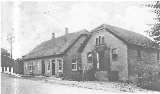
Pakhuset med påskriften "Anno 1910" og tre mænd i hjørnet. Telefonmasten kunne have 50-60 kopper med ledninger. Senere kom elmastere på vejens anden side.
