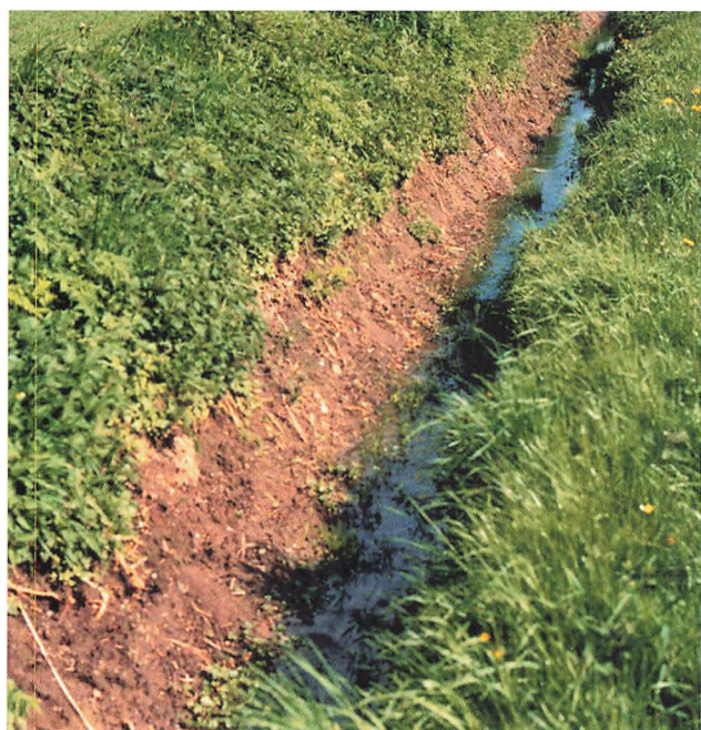
Vejgrøfter skal hvert år rettes af, så vandet i grøften kan løbe frit. Også rørlagte overgange skal efterses. Grøden lægges op på markkanten.
