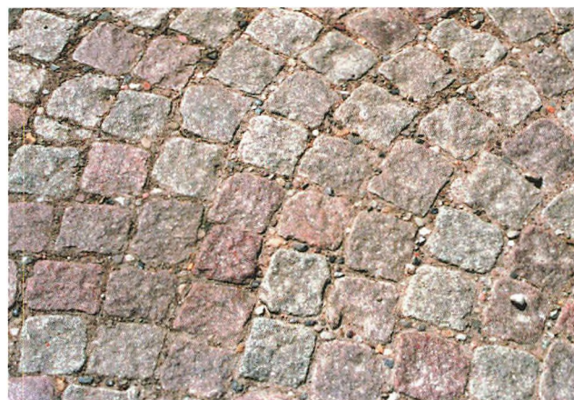
De yderste 8 meter af indkørslen er lagt med de mindre chaussesten i bueforbandt.
