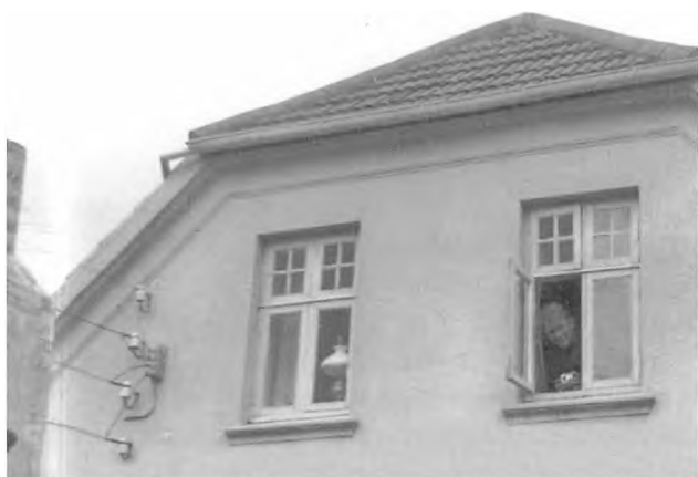
På Bramdrupvej 20 gik der 4 ledninger ind til sydsiden af huset, en til jord, en til fase 1, en til fase 2 og en til teknisk strøm = kraft. Bag Bramdrupvej 14-20 stod en fordelingsmast. Det er Anna Berthelsen, der kigger ud fra 1.sal o. 1970, og i det andet vindue ses en petroleumslampe!
