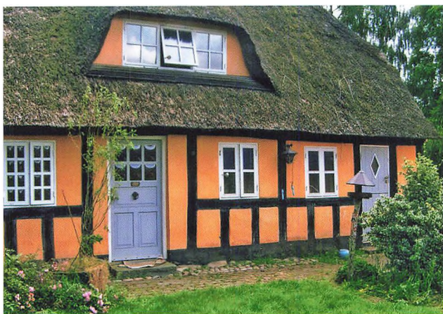
Det sidste bindingsværkshus, vi har i Bramdrup, er det gamle stuehus på Bramdruplund. Det er fra 1686. Et "fag" bindingsværk går fra en lodret stolpe til den næste.
