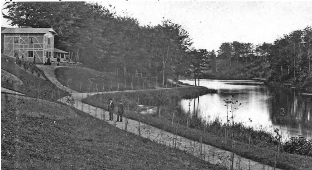
Ny pavillon i bindingsværk, med veranda og beboelse på 1. sal. Nyplantede træer ved stien.
