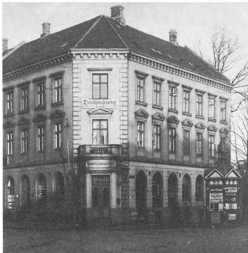
Jernbane Apotekets anden adresse. Krarups ejendom i 1889-1917, på det andet Ryesgadehjørne mod Banegårdsvejen. Her lå apoteket indtil 1923. Billedet er taget i 1916.
