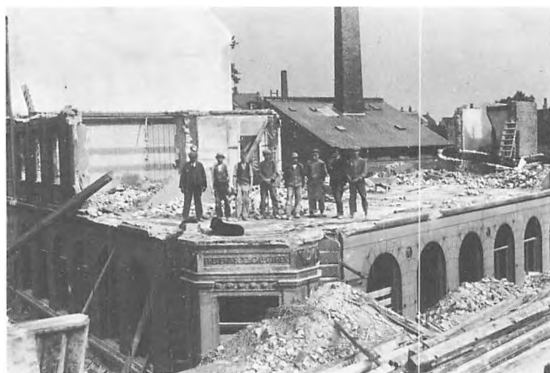
Reguleringen af Banegårdsplads betød et alvorligt afbræk i apotekets virksomhed. Billederne, der begge er fra 1923, viser øverst Banegården og til venstre apoteket set fra Ryesgade og nederst apoteksbygningen under nedrivning.
