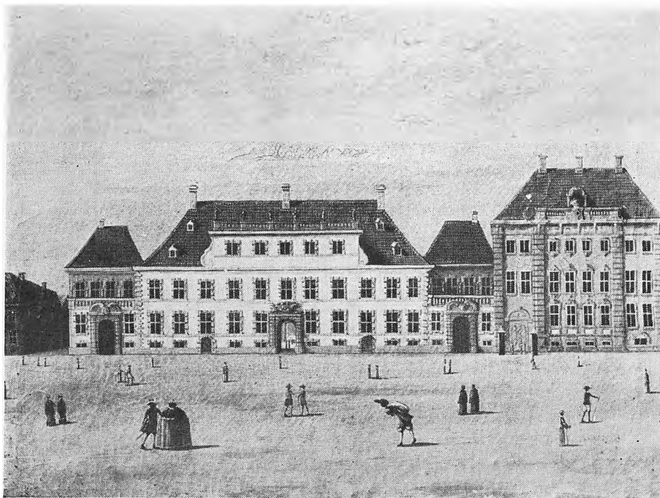
Storkansler Grev Holsteins Palæ samt Kongens Nytorv Nr. 15, paa hvilke Grunde nu Magasin du Nord's Hovedbygning er opført.
