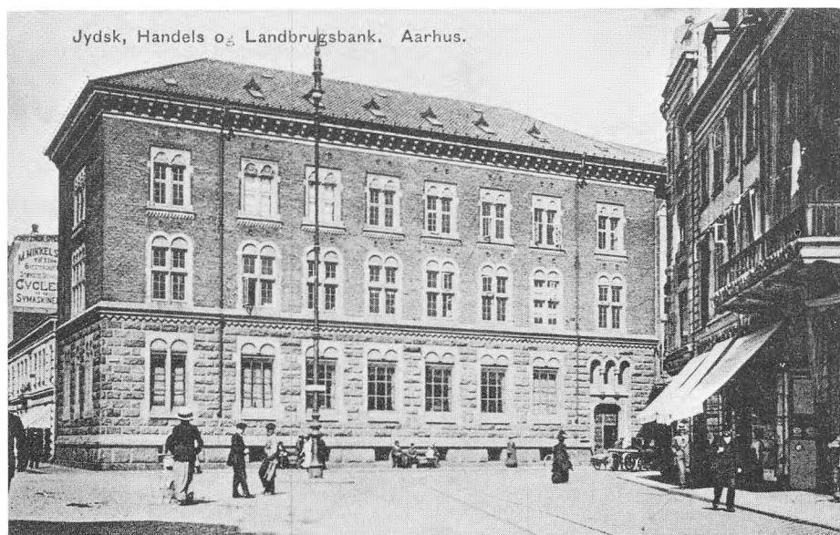
Handelsbankens hus på Lille Torv med enkeltheder af natursten, granit og sandsten i det ydre som det indre.
