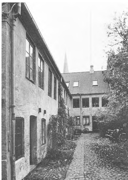
Graven nr. 8. Side/gavlhuset
