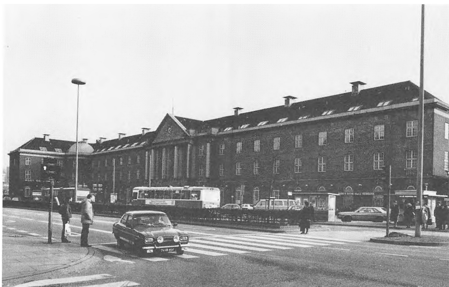
Banegårdsplads nr. 1. Århus Hovedbanegård.
