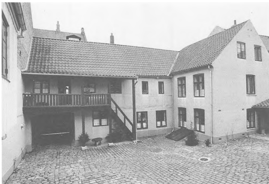
Studsgade nr. 6. Gården.
