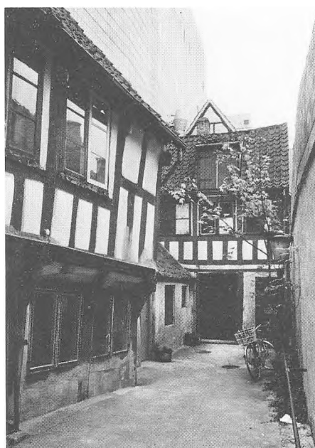
Vestergade nr. 1. Side- og baghus.
