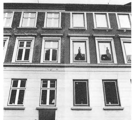
Vinduesudskiftninger til sprosseløse store termoruder berøver ofte husfacaderne væsentlige arkitektonisk betydningsfulde detaljer. Det nye spejlende, moderne glas understreger facadernes upersonlighed og fattigdom. Brammersgade 20–22.
