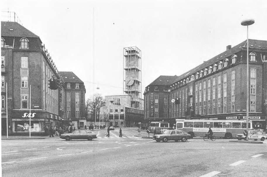
Banegårdsplads nr. 10-12 og 14-18.
