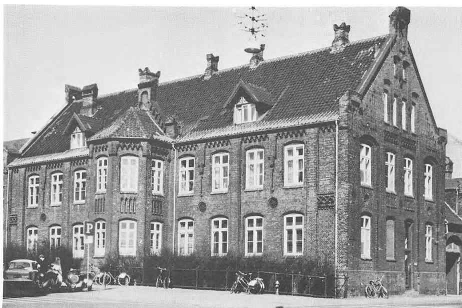
Fredensgade 36, Willemoes' hus i et kraftigt formsprog med fine teglenkeltheder.
