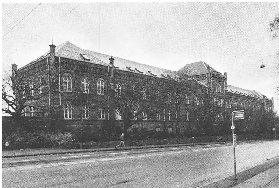
Vester Allé nr. 3. Dragonkasernens hovedbygning.
