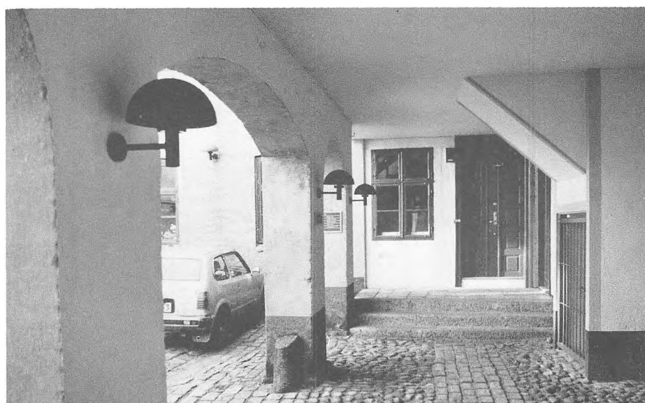
Studsgade nr. 29. Loggiaen.
