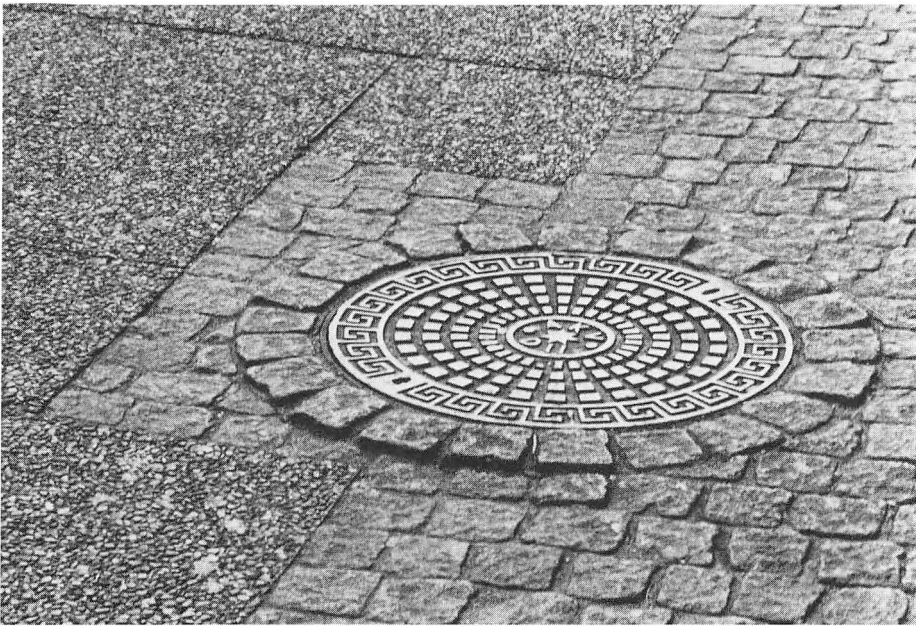
Eksempel på en betænksom belægning af fliser og chaussesten omkring et smukt støbejernsdæksel. Bispetorv.
