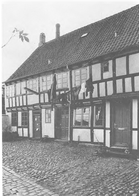
Studsgade nr. 10. Gården med sidelængen.
