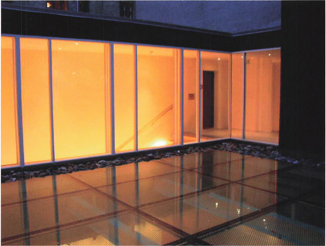
Glastag og nedgang i den nye tilbygning. (Foto: Søren Olsen).
