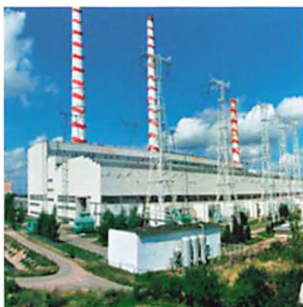
Det litauiske varmekraftværk i elektrobyen Elektrėnai indgår i vandrestillingen Drømme- fabrikker
