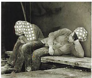
Rørisoleringspiger. Elektrenai Kraftværkets Fotoarkiv, Litauen
