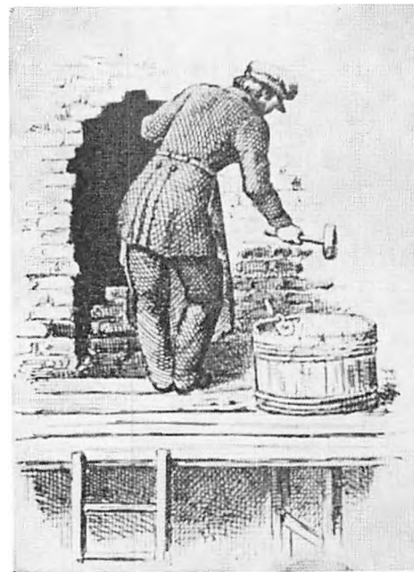
En murer på sit stillads. Bemærk hans påklædning, der har et helt uniformsagtigt præg.
