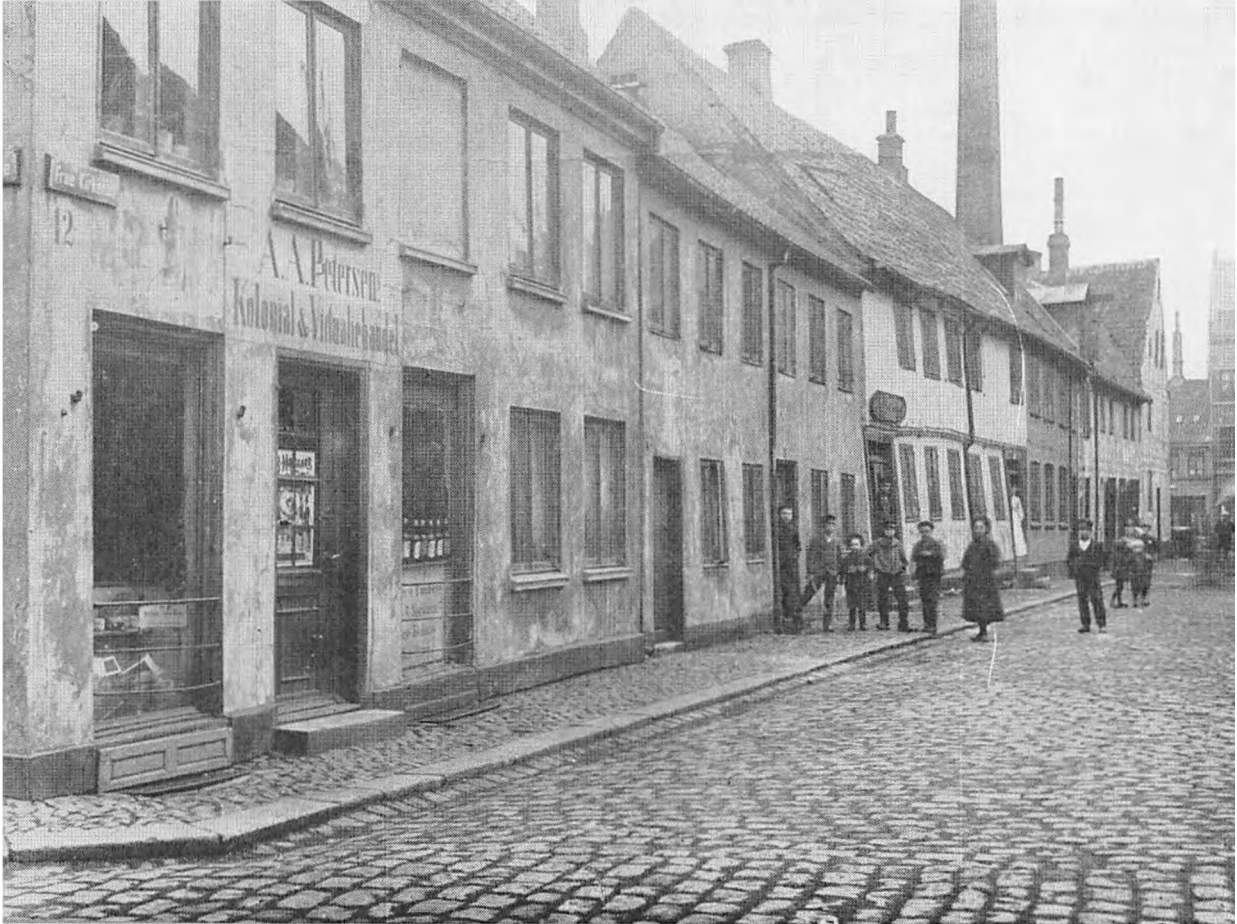
Frue Kirkerist mellem klosteret og Guldmedgade, der skimtes i billedets baggrund. Hjørneejendommen Frue Kirkerist nr. 12 ligger samtidig i Hospitalsgade.
