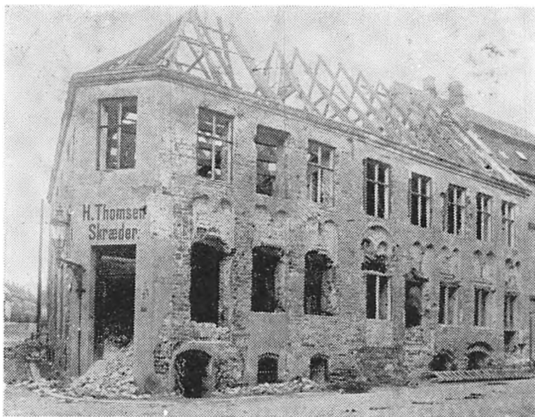
Budolfi kloster under nedrivning
