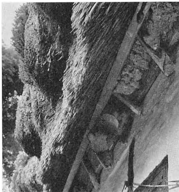
Fig. 3. Tagskægget ved gavlen. Med mellemrum ses det nederste af de skrat opdragende pinde, som forsvinder op i tagets to lag tekkemateriale, nederst strolaget af halm, derover tangen. (Dansk Folkemuseum, Peter Michelsen fot. 1952).
