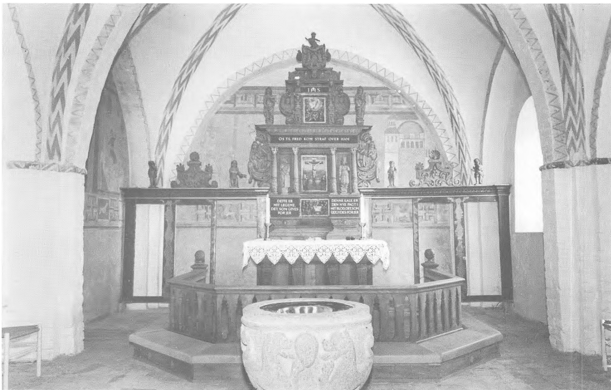
Hvorslev kirke, set op mod alteret, under restaurering.
