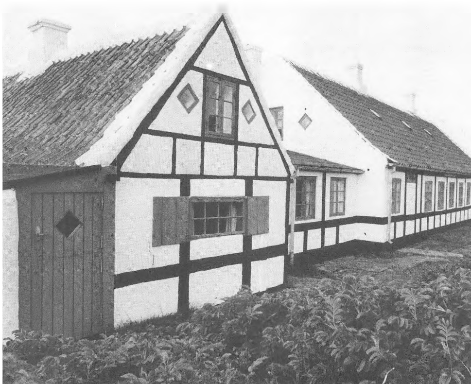
I de gamle Skagenhuse knirker og knager det plyndrede gods
