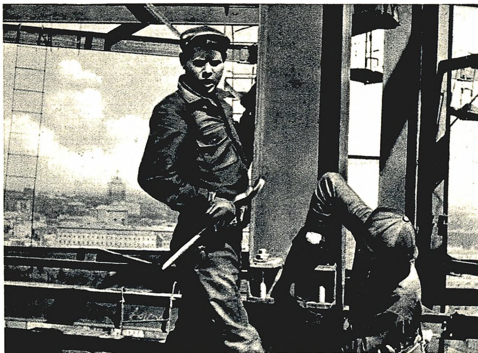
A. OSSETSCHKIN, Hochbaumenteur: „Das Haus, das wir jetzt bauen, wird eins der höchsten Häuser Moskaus werden. Ich arbeite gerade am 27. Stockwerk. Im 5. Stock sind schon einige Wohnungen fertig. Wie schön und bequem sie sind! Einfache Sowjetmenschen werden darin wohnen. Und wieviel Häuser in Moskau und anderen Städten noch gebaut werden! Wir werden nicht zulassen, daß das Werk unserer Hände in einen Trümmerhaufen verwandelt wird!“
