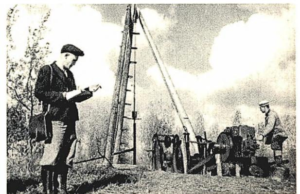
Der Geologe W. Akischin stellt auf dem Baugelände des Kuibyschewer Großkraftwerks Filtrierungsversuche an
