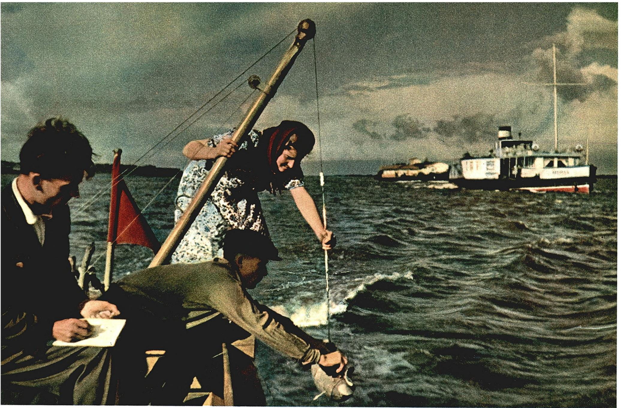
Die Planer und Erbauer des Stalingrader Wasserkraftwerks müssen das Wasserregime der Wolga genau kennen. Unser Bild: Hydrologen messen die Stromgeschwindigkeit
