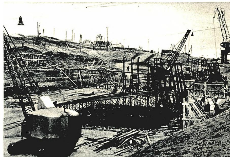
Im Jahre 1951 wird der Bau des Wolga-Don-Schiffahrtskanals beendet und so eine durchgehende Wasserstraße geschaffen, die alle den europäischen Teil der Sowjetunion umspülenden Meere miteinander verbindet. Der Bau ist mit den modernsten Maschinen ausgerüstet; auch in den Wintermonaten wird hier mit Volldampf gearbeitet. Unser Bild: Armierung des Sohlengewölbes einer Kanalschleuse
