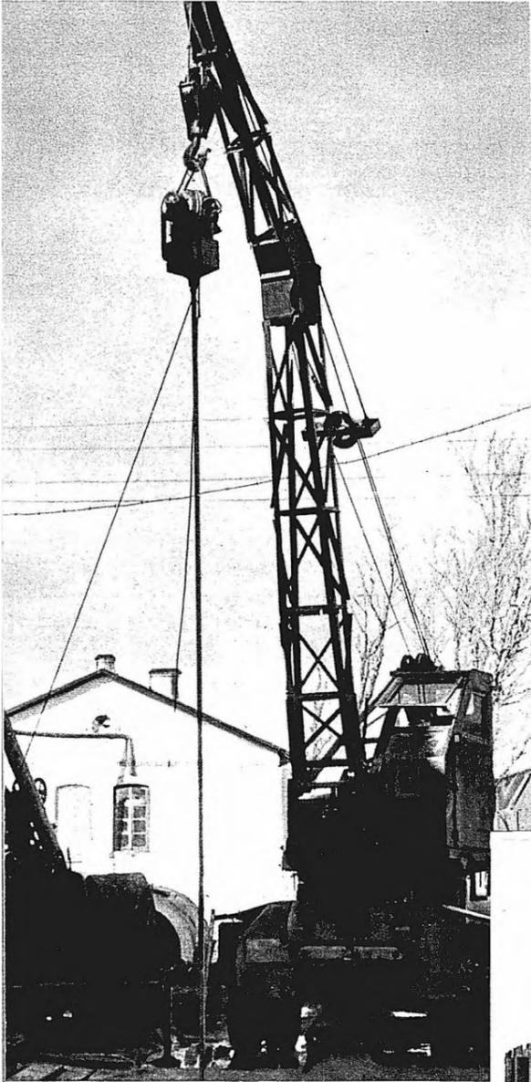
Das Anlegen eines Schurfbohrloches im Schwingungsverfahren
