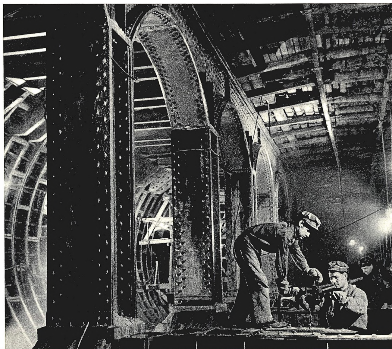
Unten: Montage der Bodenbalkendecke in einer Halle der Station „Komsomolskaja-Kolzewaja“
