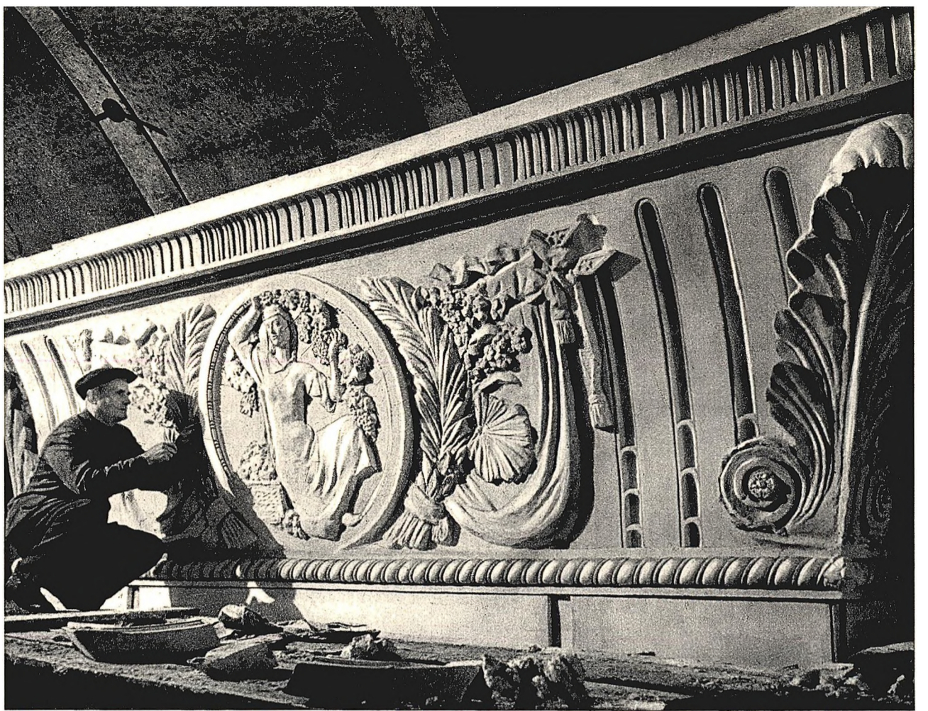
Keramikkartusche für die Pfeilerverkleidungen der Station „Botanitscheski Ssad“ in Arbeit
