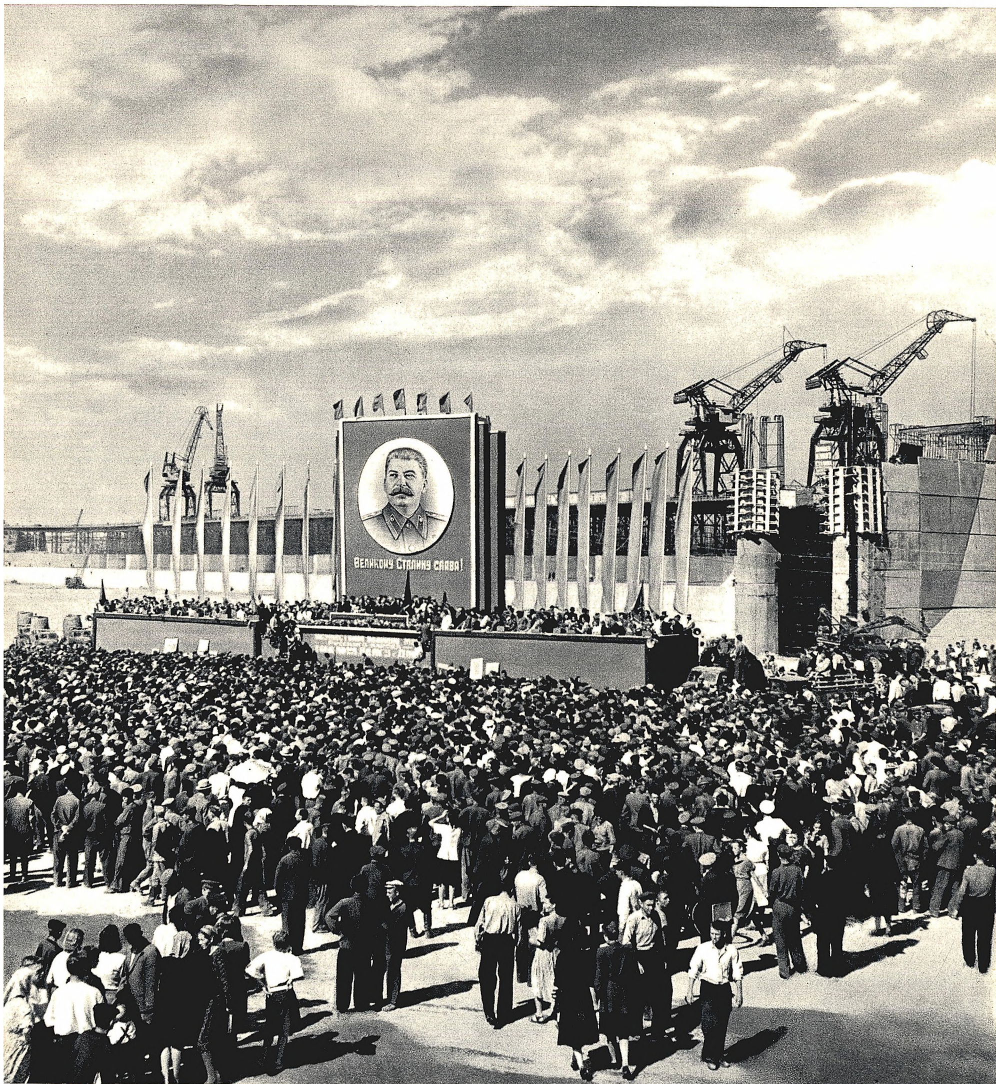
Im September kam auf dem Baugelände der hydratechnischen Großanlage Zimljanskaja eine wichtige Arbeitsetappe zum Abschluß: in ein neues Bett geleitet, strömte das Donwasser über den Beton der Zimljanskajaer Überfallmauer. Unser Bild: Kundgebung der Arbeiter, Ingenieure und Techniker vor dem Einlassen des Donwassers in das neue Flußbett
