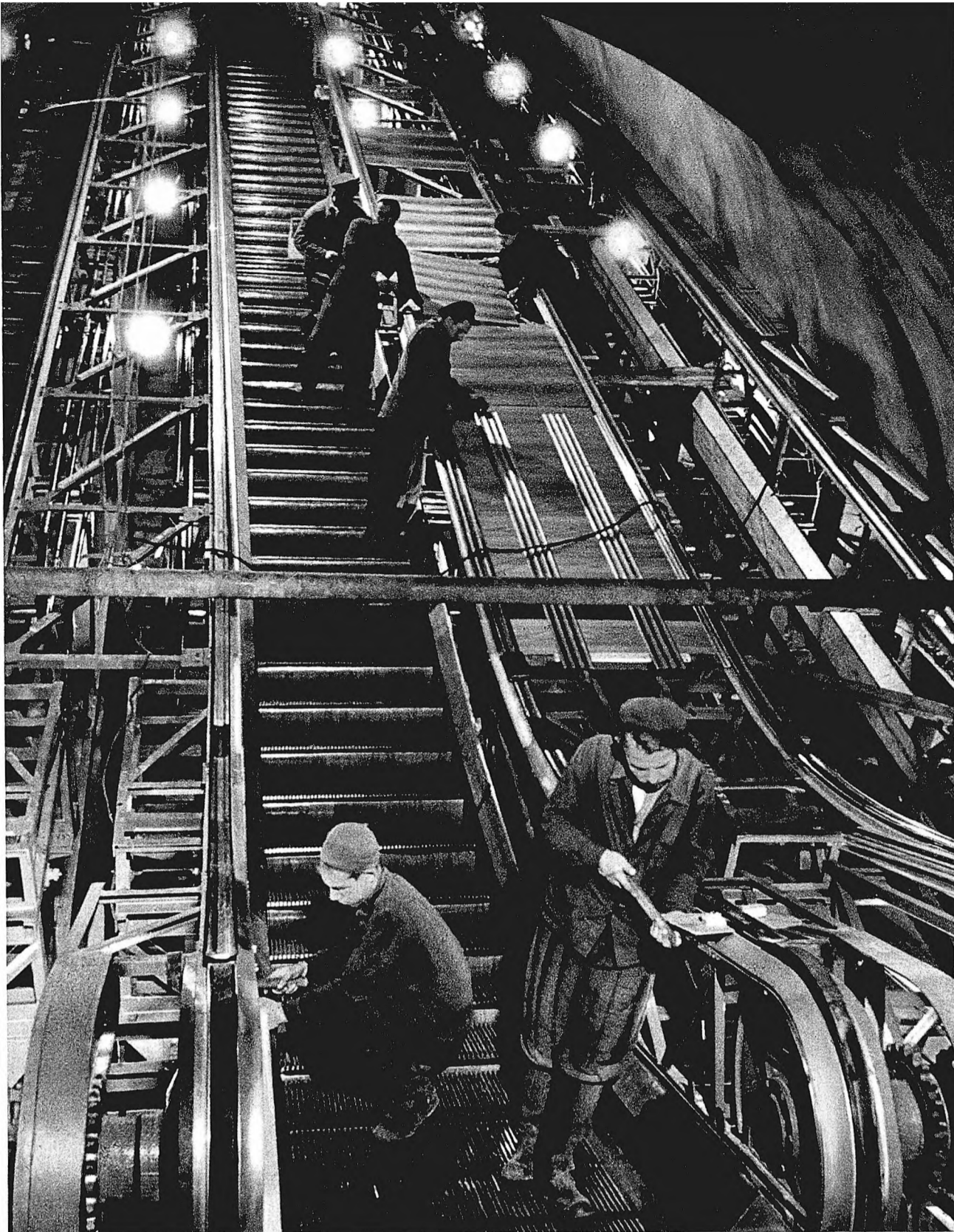
Montage der geräuschlosen Rolltreppe auf der Station „Botanitscheski Ssad“
