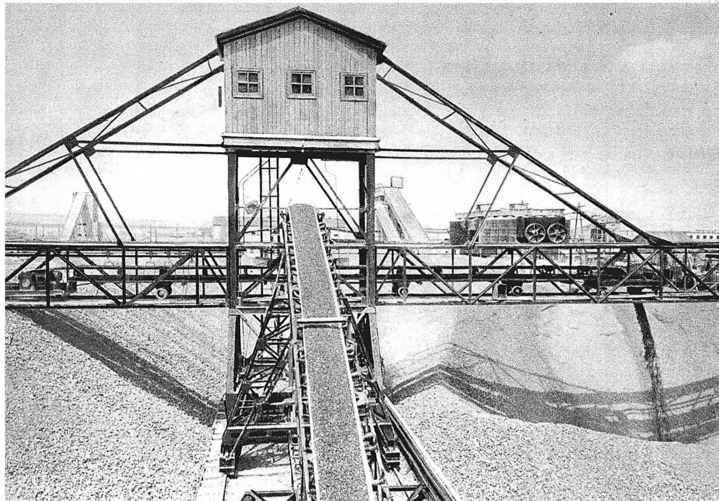
Mechanische Vorrichtungen entladen den Steinschlag aus den Güterwagen in den Lagerhof
