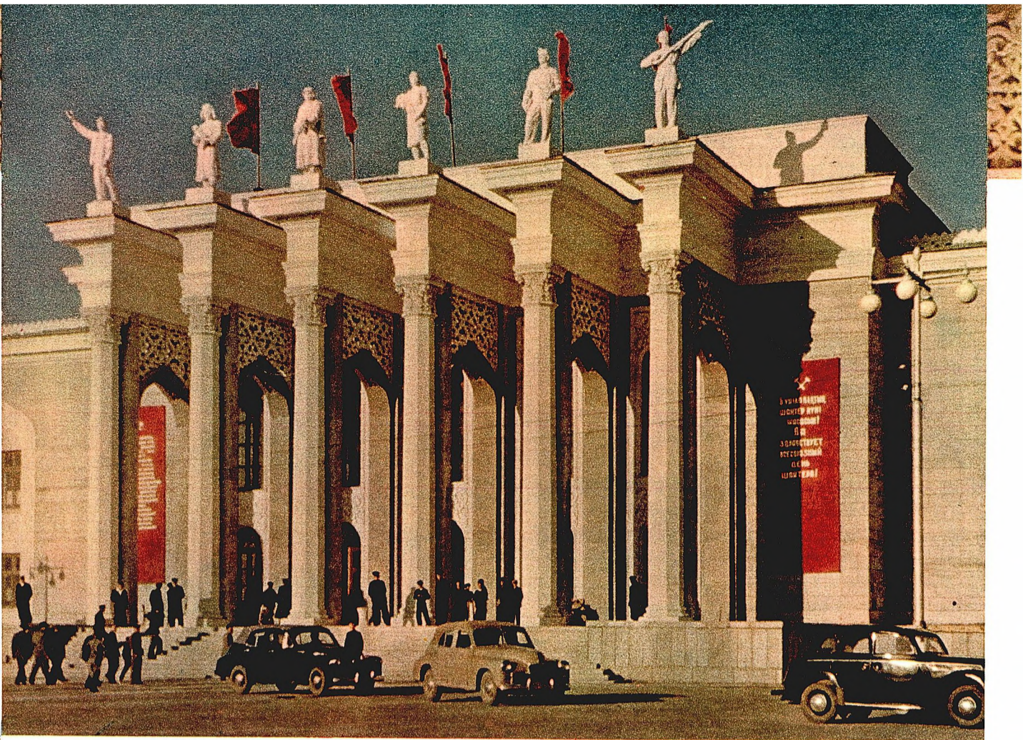
Die Fassade des Kulturpalastes
