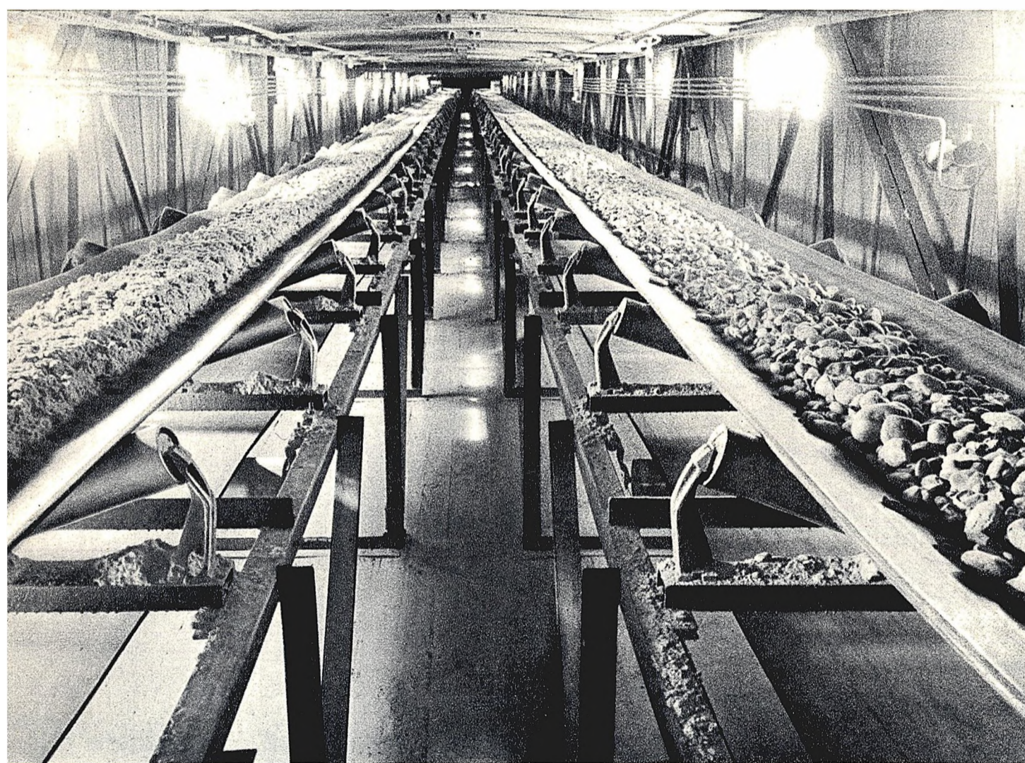
Durch eine Schräggalerie gelangen Sand und Steinschlag auf Bandförderern in die Fabrik
