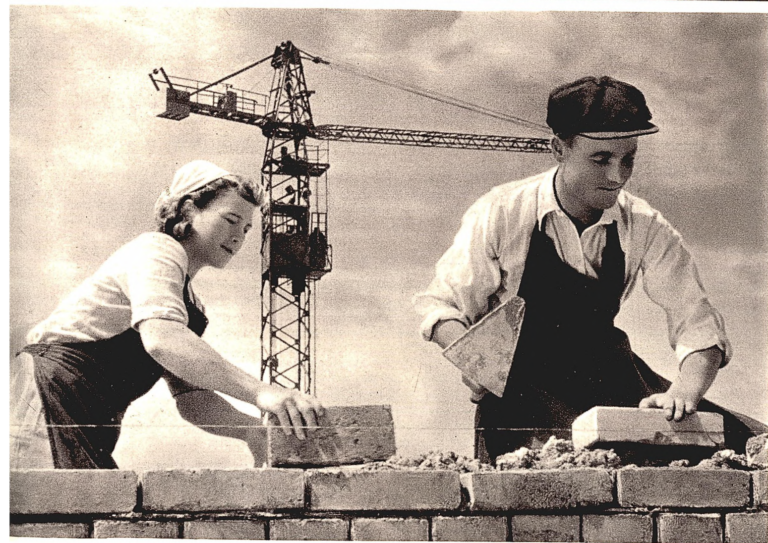
Oben: Teilansicht des Baugeländes in dem neuen Magnitogorsker Stadtteil am rechten Ufer des Uralflusses. Zweites Bild: Die jungen Stachanowmaurer Tatjana Trutnewa und Nikolai Frolov bei der Arbeit
