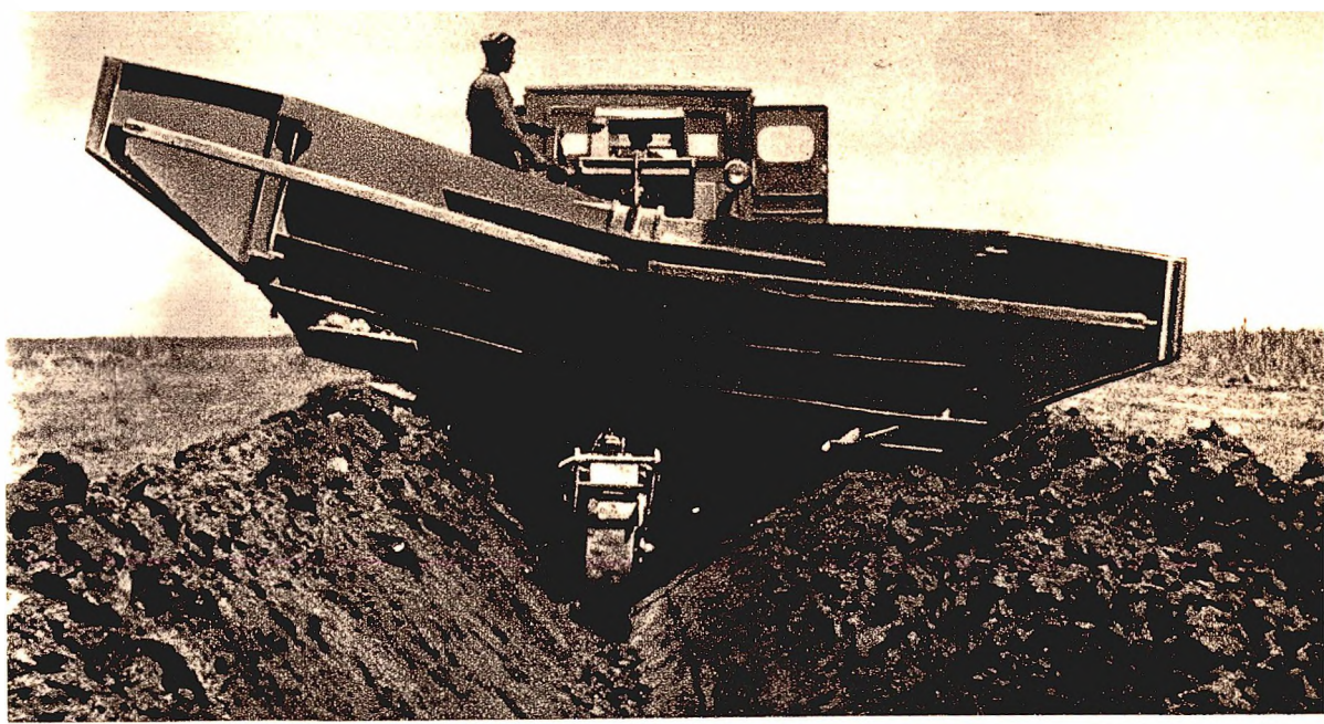
Ein neuer mächtiger Grabenpflug zieht einen Bewässerungsgraben in der Hungersteppe
