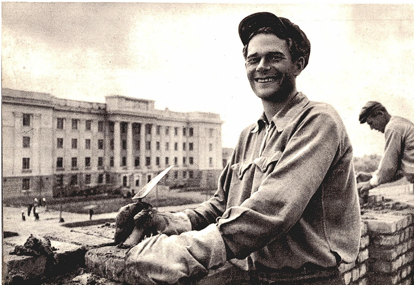
TULA. An Stelle der von faschistischen Bomben und Granaten zerstörten Häuser entstehen neue Gebäude. Viele Bauarbeiter sind ehemalige Kämpfer der Sowjetarmee; so auch der Maurer Ilja Tokmakow, der auf einem Wohnbau an der Kommunardenstraße arbeitet
