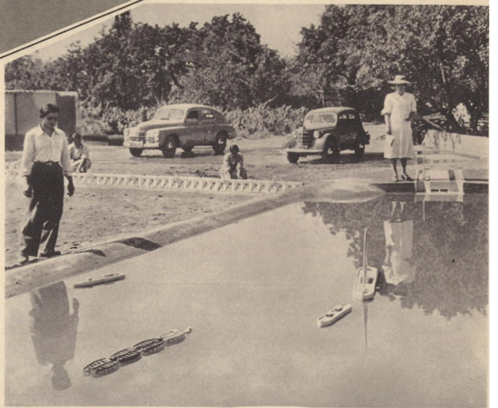
Um die Richtung der Strömungen festzustellen, verfolgen wissenschaftliche Mitarbeiter aufmerksam jede Bewegung der winzigen „Dampfer“ und „Lastkähne“ auf dem Schleusensee
