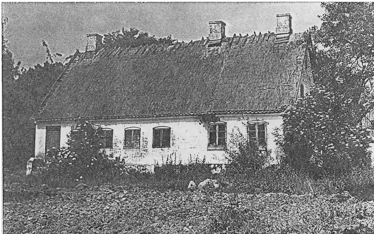
Gl. HØJGÅRD - nedrevet - lå ved siden af BROGÅRD
