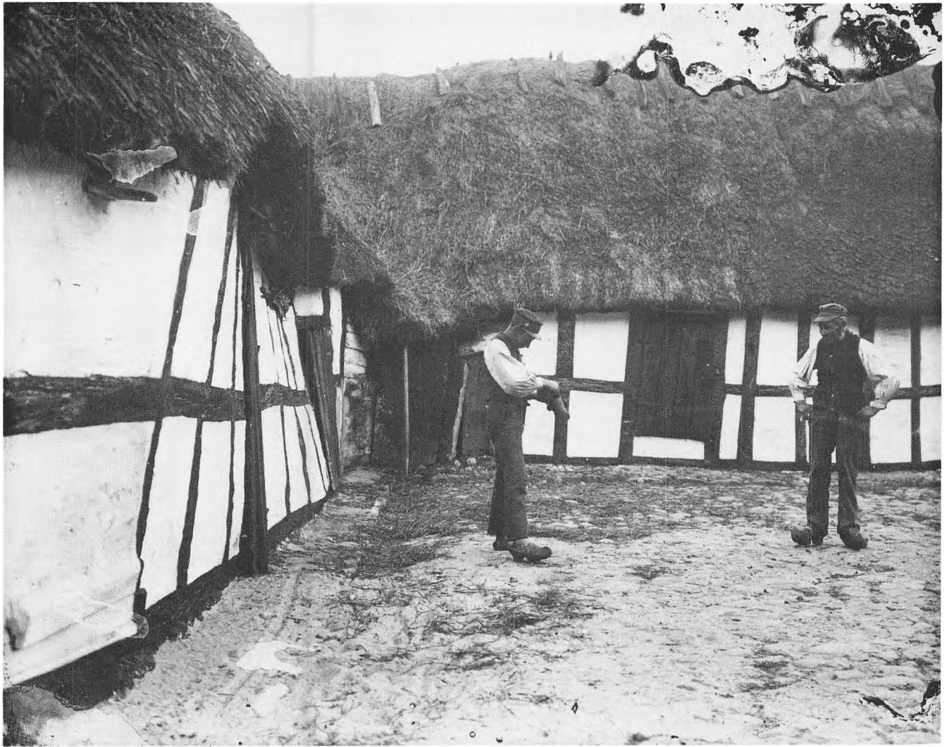
»Væggene lidt skæve stå« konstaterede Søren Lolk da han tog dette billede af en gammel gård på Drejø. Det sejge bindingsværk forhindrede murene i at falde, men fornyelsen kom — omend på lovlig dramatisk vis — ved katastrofebranden i 1942, da det meste af Drejø by gik op i luer.
