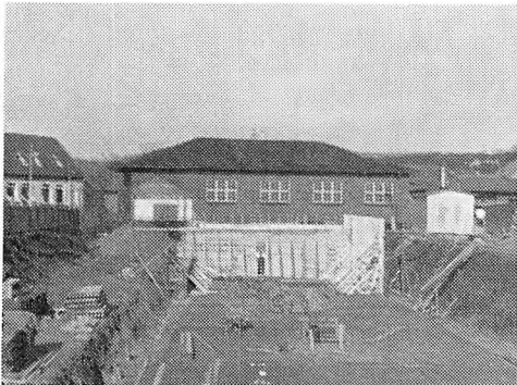
– Støberiarbejdet under den nye klassefløj er påbegyndt, drengenes gymnastiksal endnu ikke nedrevet.
