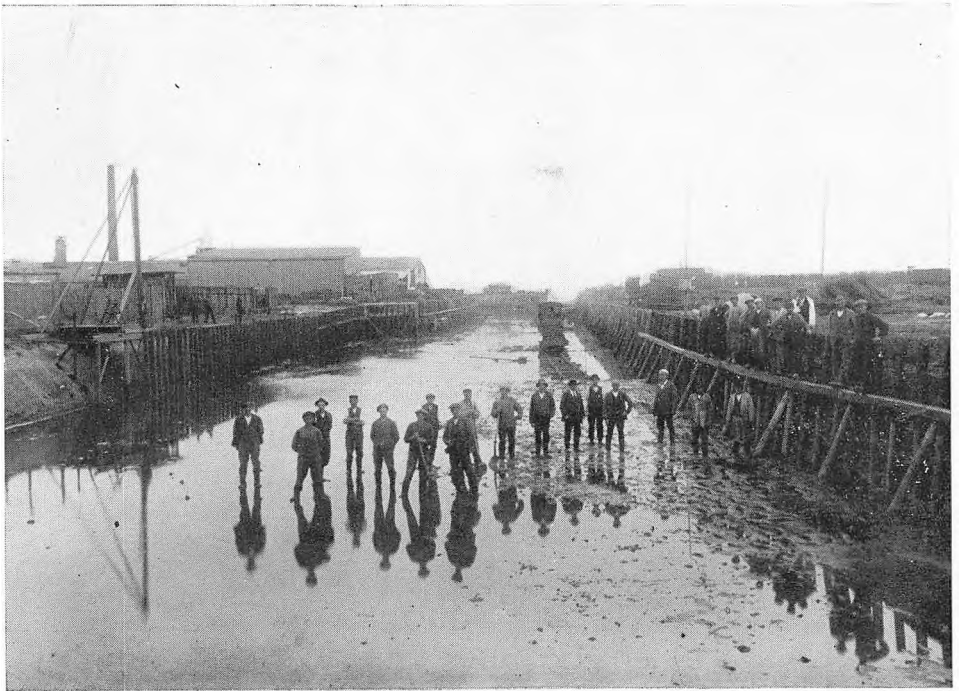
Arbejdet ved Aaførelsen. 1916.
