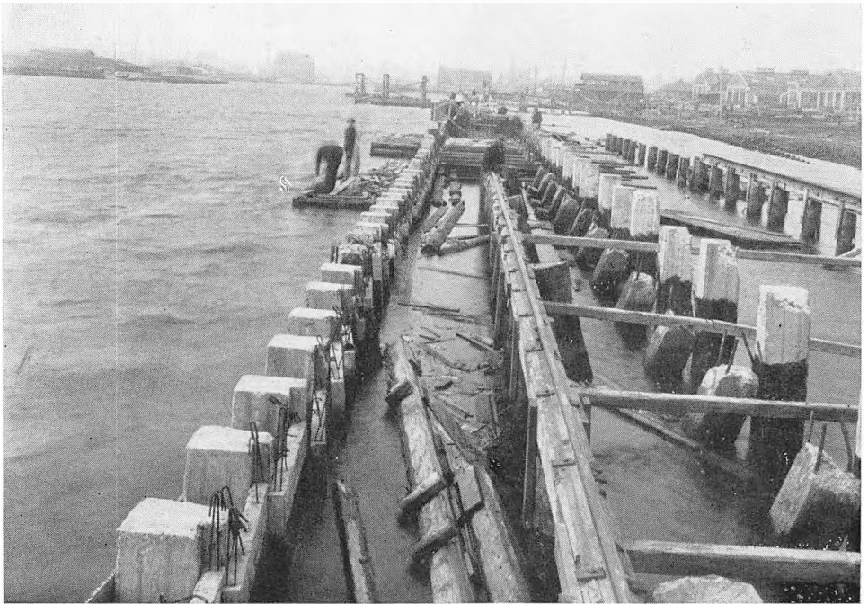
Kajanlæg paa Nordsiden, 1920.
