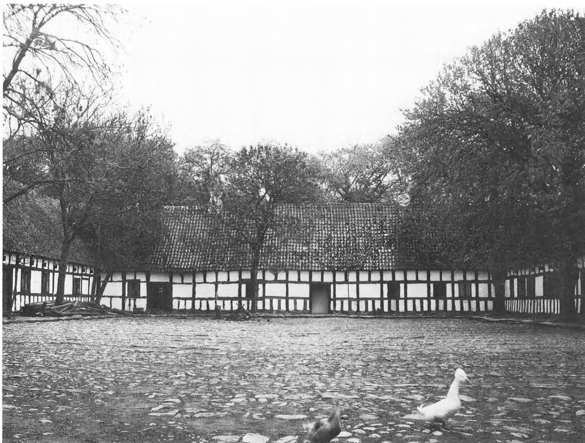
Fig. 1. Den stenpikkede gårdsplads med østre længe i baggrunden. Foto H. Matthiessen 1934. – The stone-paved courtyard with the eastern wing in the background. Photo: H. Matthiessen, 1934.
