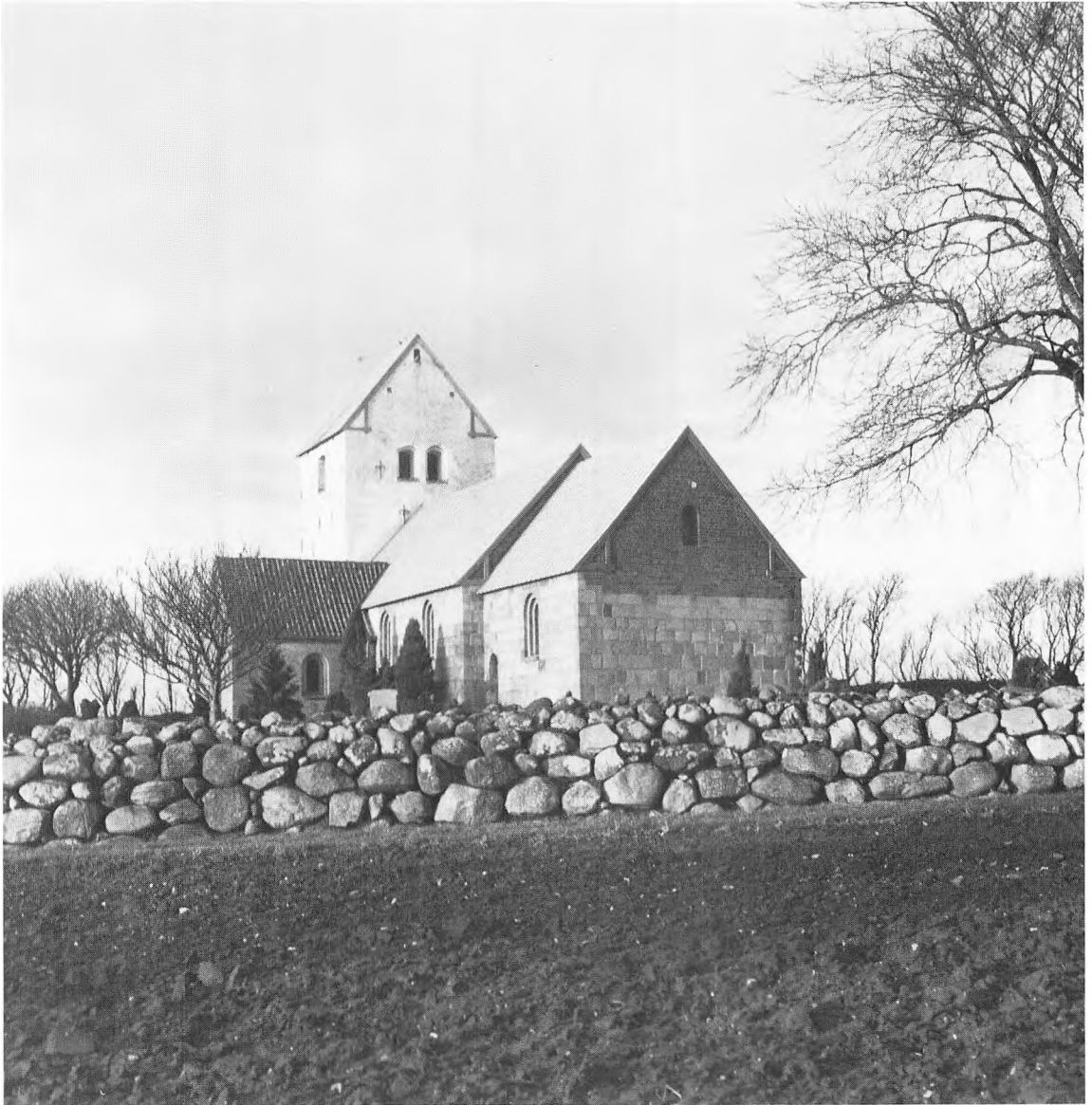
Fig. 1. Aggersborg kirke og østsiden af det mægtige kampestensdige. Foto Henrik Græbe 1982. Nationalmuseet. – Aggersborg Church and the eastern side of the big stone wall. Photo: Henrik Græbe, 1982. National Museum.
