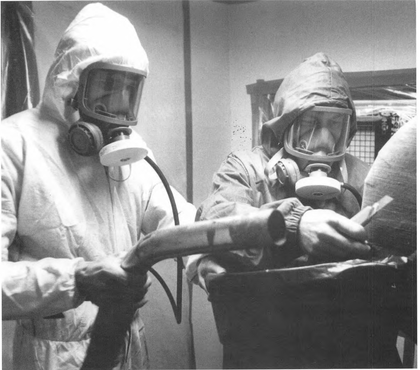
Asbestsanering i rumdragter.
