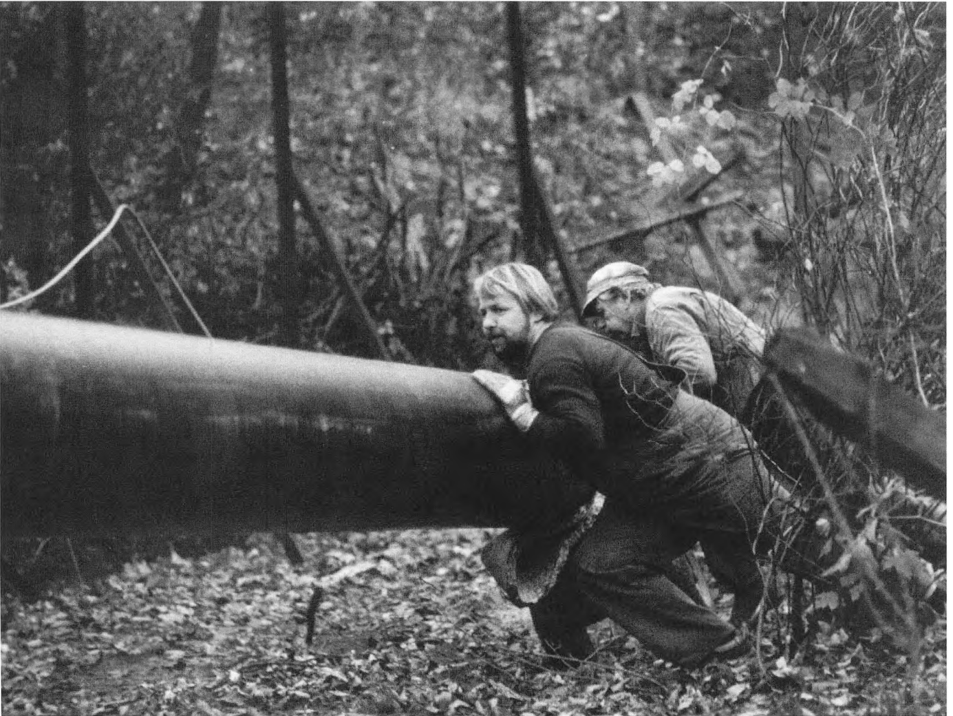
Der lægges fjernvarmerør af John Antonsen og nu afdøde Kjeld Jensen på voldterrænet bag ved Langebrogade i 1985.
