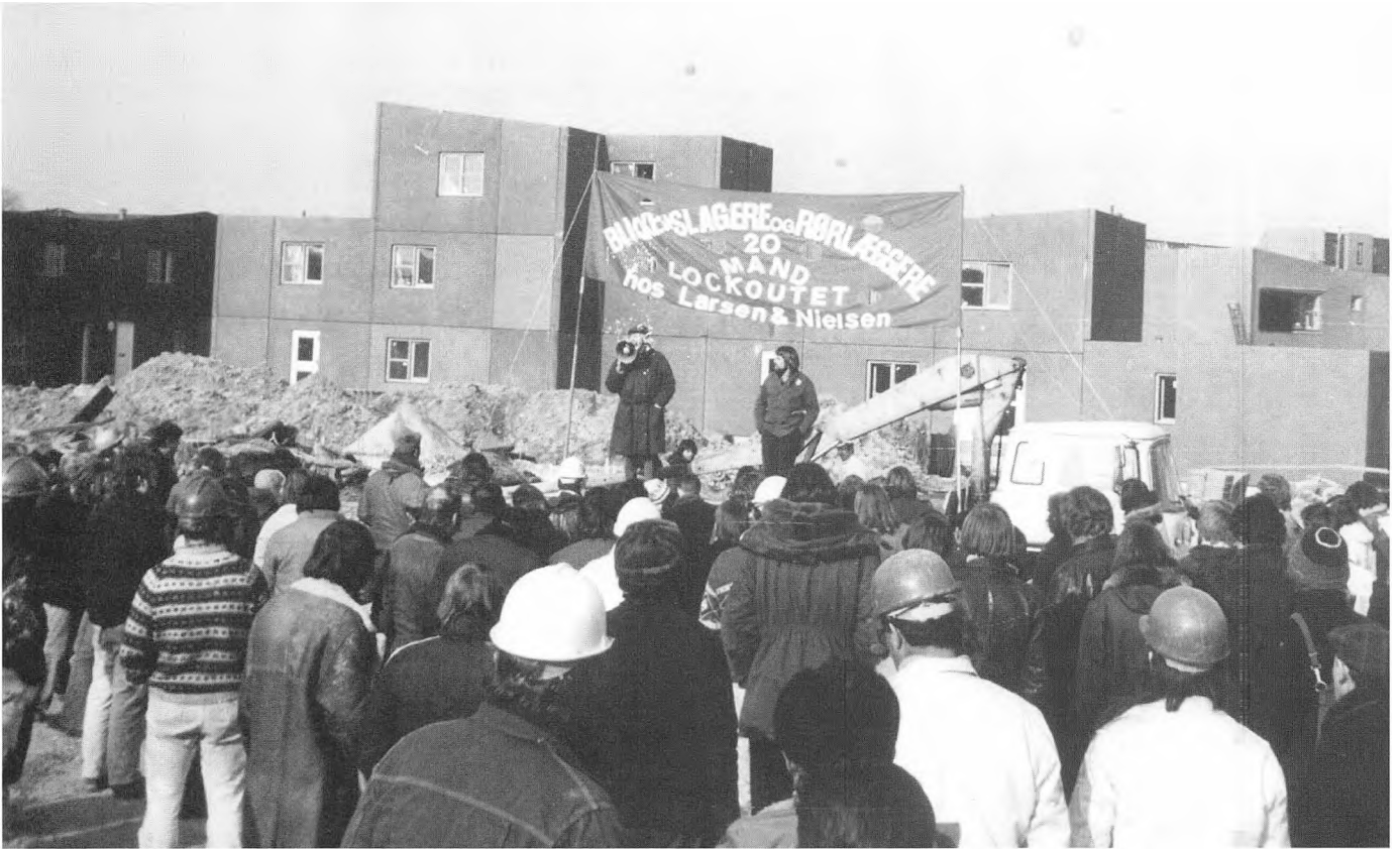
Lockout-møde ved byggeriet Hyldebjergvej.
