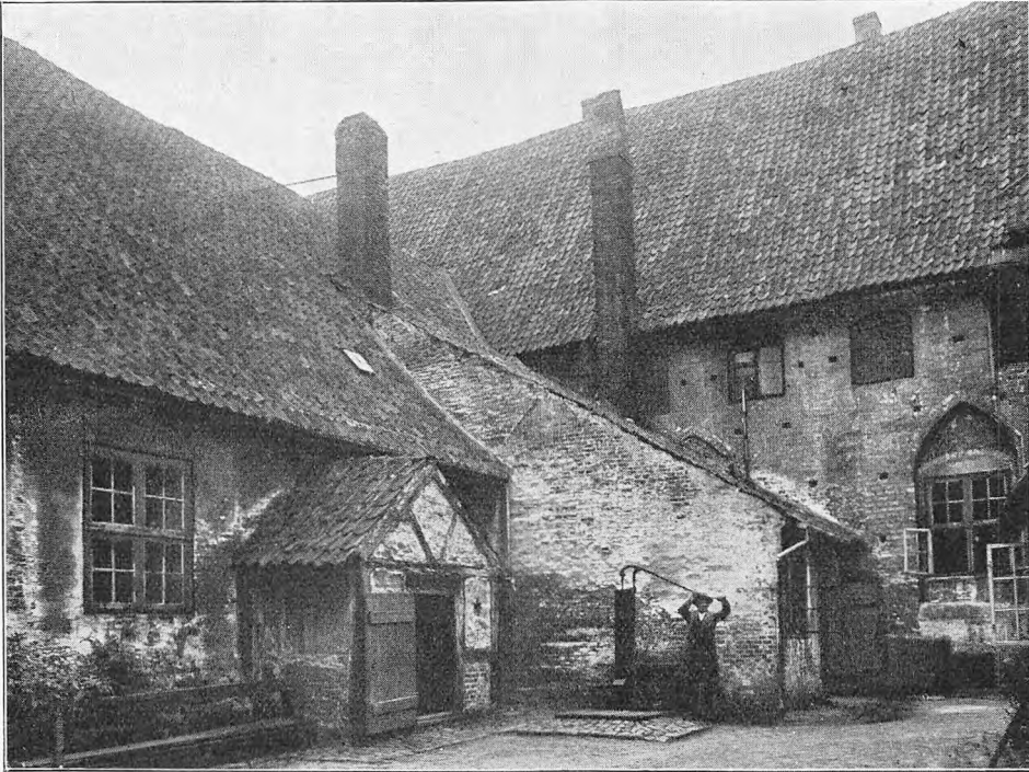
Den 1754 opførte, ved Restaureringen nedrevne, Tilbygning til Karmeliterklosterets østlige Fløj. Denne Tilbygning og Laxmandsalen udgjorde tilsammen det Rum, hvori »de gamle Koner« boede.
