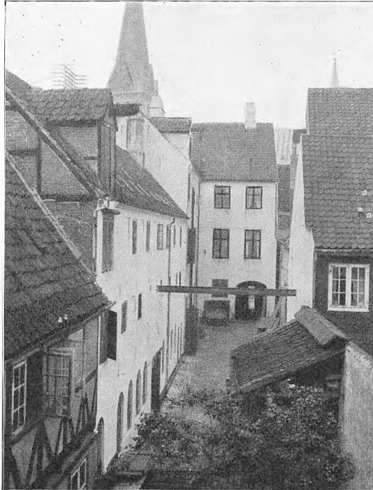
Udsigt gennem Strandgade 91 (B. 11) og Stengade 78 (B. 24), der tidligere udgjorde een Gaard.
