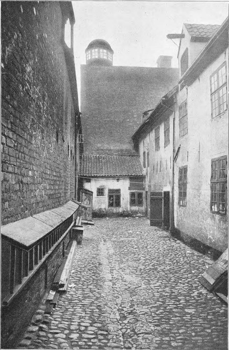
Til højre Stengade 68 (B. 19), til venstre Bagmuren af Stengade 70 (B. 20), Borgmester Fr. Lejels Gaard. I Baggrunden en Kikkenborg fra det 18de Aarhundrede (af Kircks Gaard, Strandgade 81, B. 14, I. 353—54).
