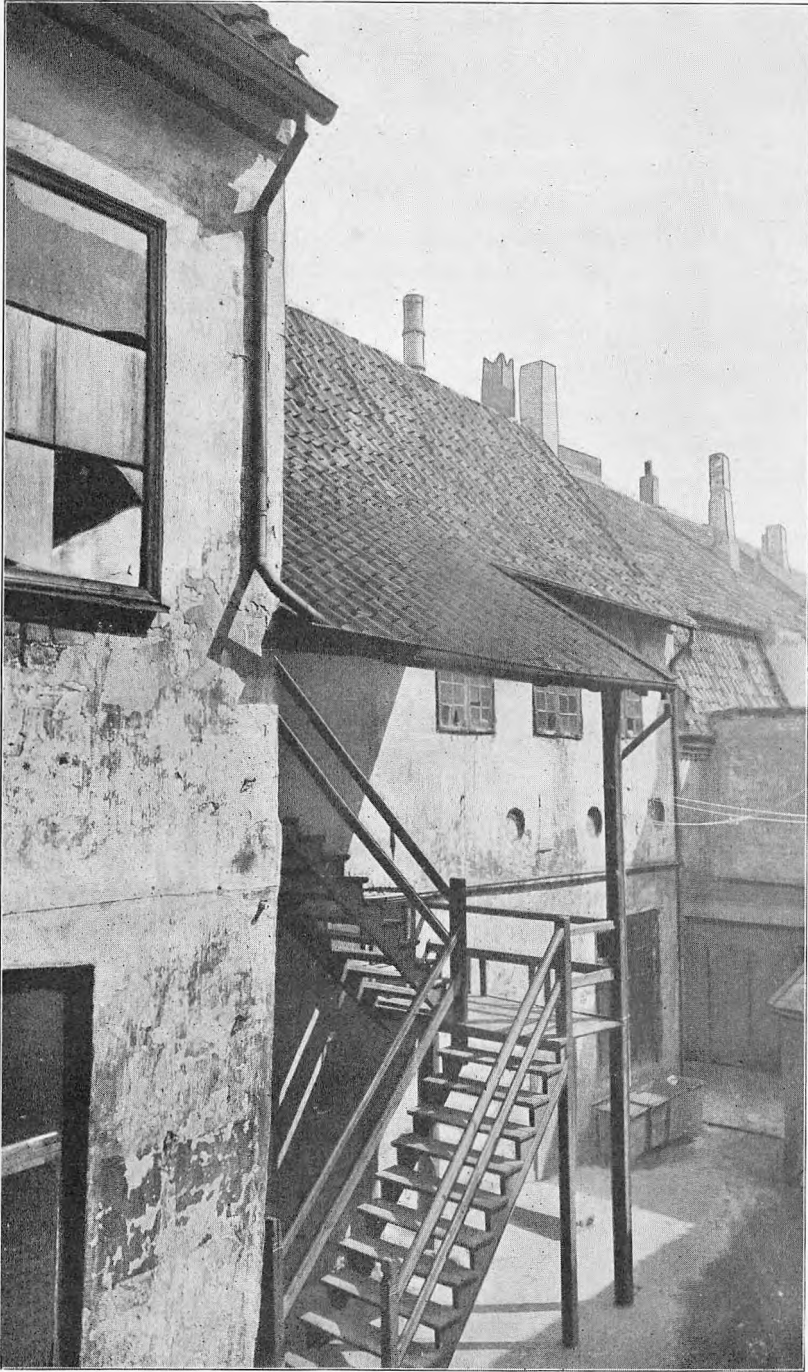
En af Lejelernes Gaarde, Stengade 74 (B. 22). Bygningen er et Gavllhus og Bebyggelsesplanen karakteristisk for den senere Middelalder. Grundplan, se I. 423.
