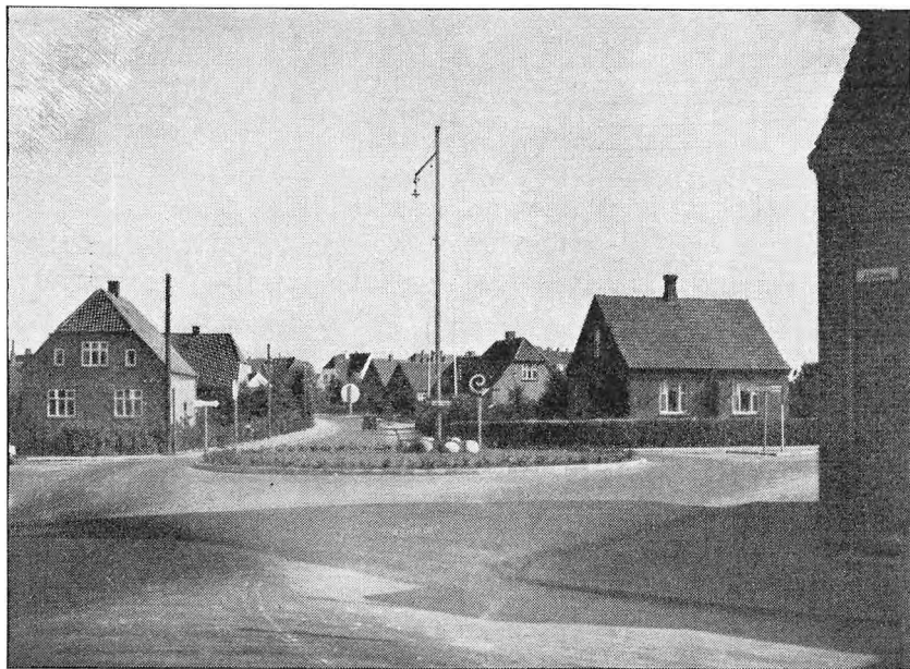
Rundkørsel i Vejkrydset Østergade—Vindingevej—Hedegaardsvej.
