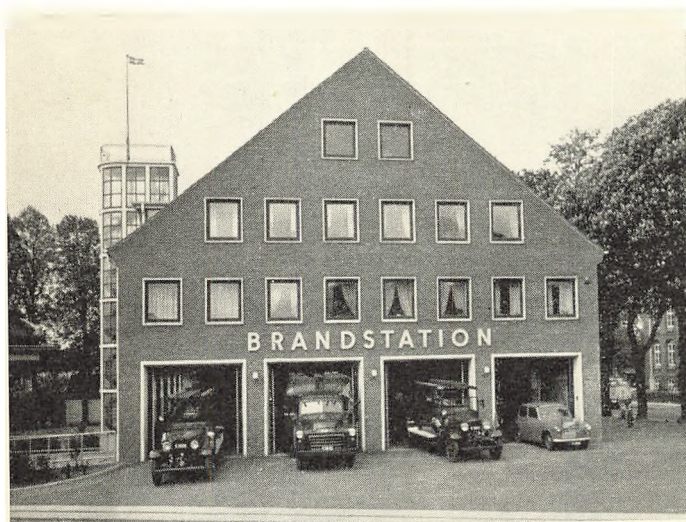
Sønderborgs nye, flotte brandstation, der blev indviet den 19. november 1950. Bygningen er 16\frac{1}{2} m bred og 21\frac{1}{2} m lang. Under hele huset er der kælder med bl. a. et 8 \times 8 m stort beskyttelsesrum, 2 værksteder for brandmænd og en vaskehal til slanger og vogne i hele husets bredde med direkte tilkørsel. Tårnet er 17\frac{1}{2} m højt og har plads til 700 m slange på en gang. Een mand kan hejse dem op og ned fra samme sted i vaskehallen ved en særlig og meget moderne anordning. I stueetagen findes brandstationen med 4 porte, 215 \text{ m}^2 vognhal, værksted for depotmesteren, bad og w. c. til mandskabet, musik- og mødelokale samt brandinspektørens kontor. På første og anden sal er der indrettet 8 moderne lejligheder til brandmænd.
