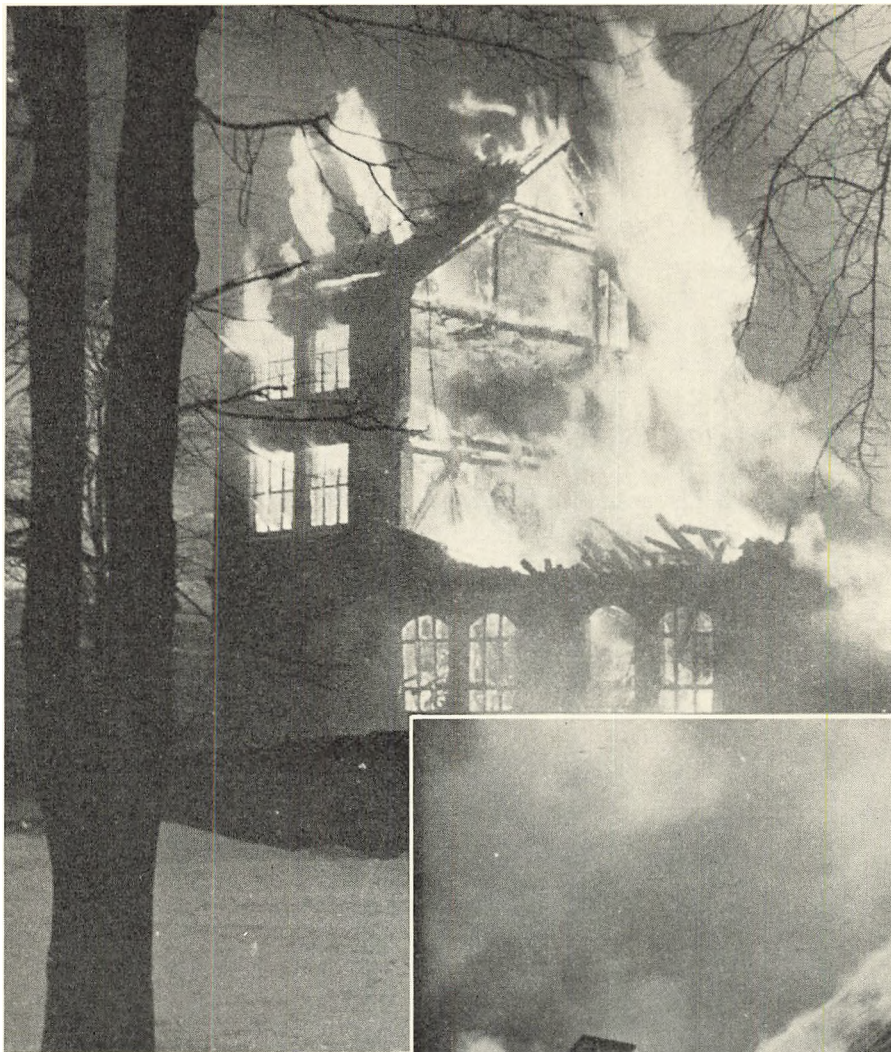
Fabriken „Torotor“s brand den 11. marts 1947. Efter en sabotage-sprængning i 1945 var gavlen midlertidig erstattet af en brædevæg, hvorfor ilden hurtigt bredte sig til hele bygningen.
