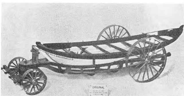
Model af den første engelske redningsbåd, der byggedes i 1789 og som var monteret på en særlig transportvogn.
