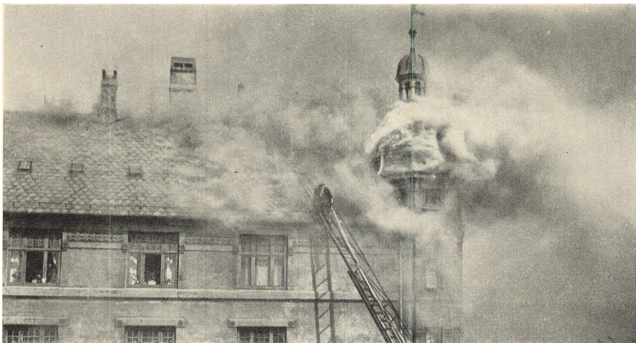
En af de typiske tagbrande, der koster forsikringselskaberne så mange penge. Tagetagens særlig brandfarlige konstruktioner medfører næsten altid meget omfattende brande.
