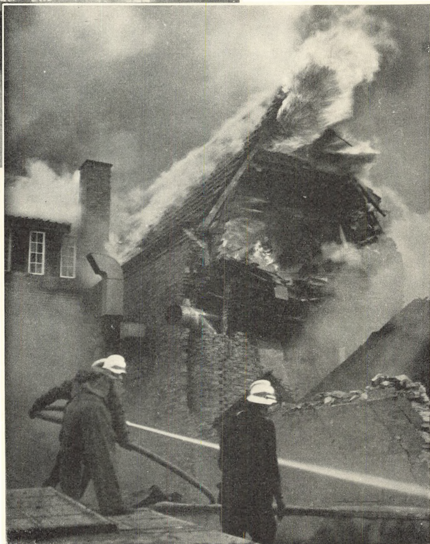
Fra brand i en møbelfabrik på Saantesvej i 1951. Fra træbearbejdningsmaskinerne sugedes spåner og savsmuld til et særligt rum i gavlen. Her faldt gnister fra en skorstens ild ind i udsugningsanlægget, der antændte en blanding af savsmuld og luft hvilket forårsagede en kraftig eksplosion.
