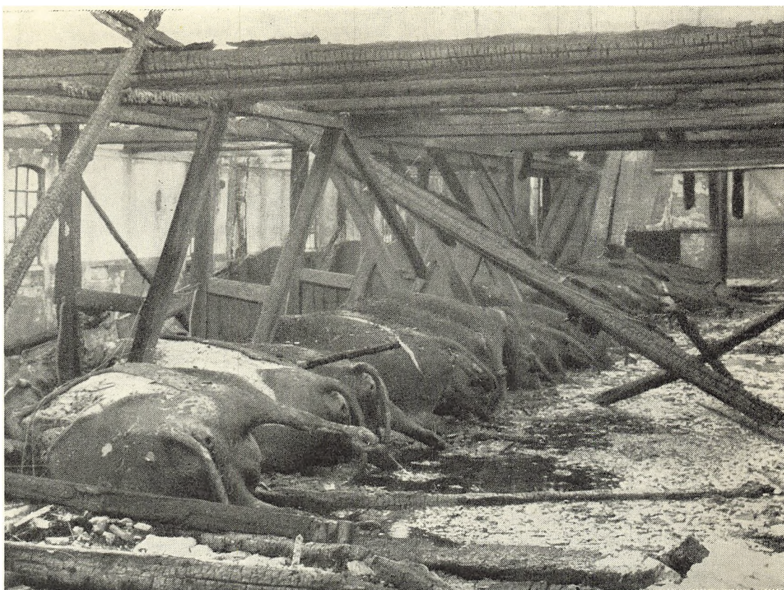
Dette triste syn møder ofte brandmanden efter en brand på landet, og skyldes som oftest, at der intet er gjort for at sikre loftet over stalden mod for hurtig gennembrænding.
