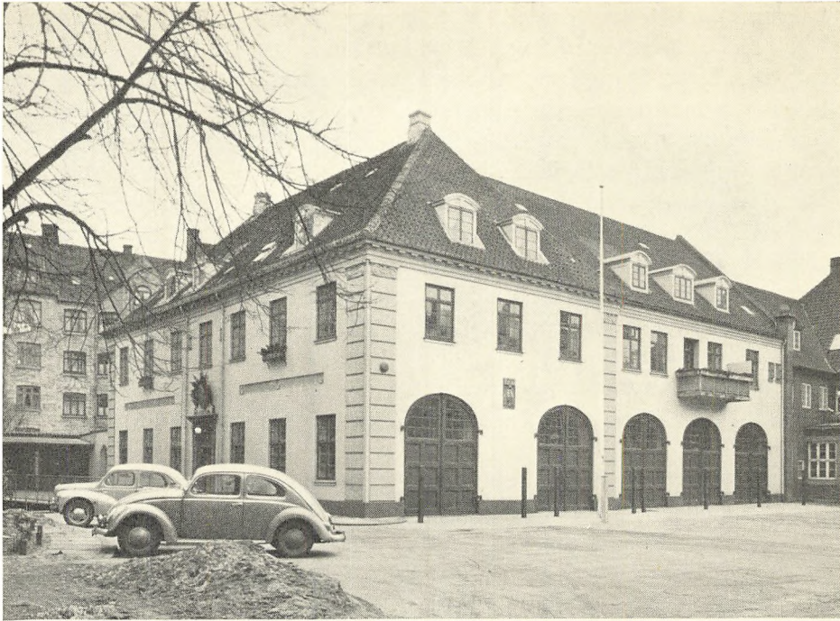
Aalborg brandvæsens centralt beliggende brandstation blev opført i 1914.
