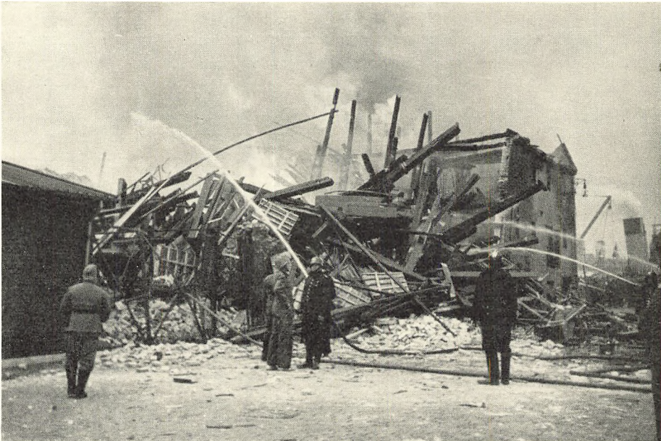
Da luftangrebet først satte ind 10 minutter efter alarmen, var brandvæsenet rede til at sætte alt ind, og branden, der kunne have haft katastrofale følger, blev derfor begrænset til en 3 etagers lagerbygning.
