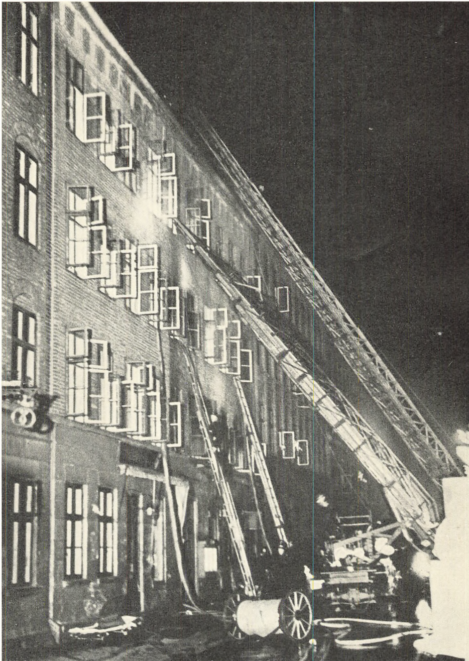
En særlig farlig brand indtraf i maj 1939 i Danmarksgade i en af de brandfarlige een-trappe ejendomme, der stammer fra før brandlovens tid. At branden fik et trods alt mindre omfang, end man skulle have ventet, var en bedrift af det frederiksbergske brandmandskab. Ad stigen, der på billedet ses sat til vinduerne på tredje sal, reddedes 18 mennesker.
