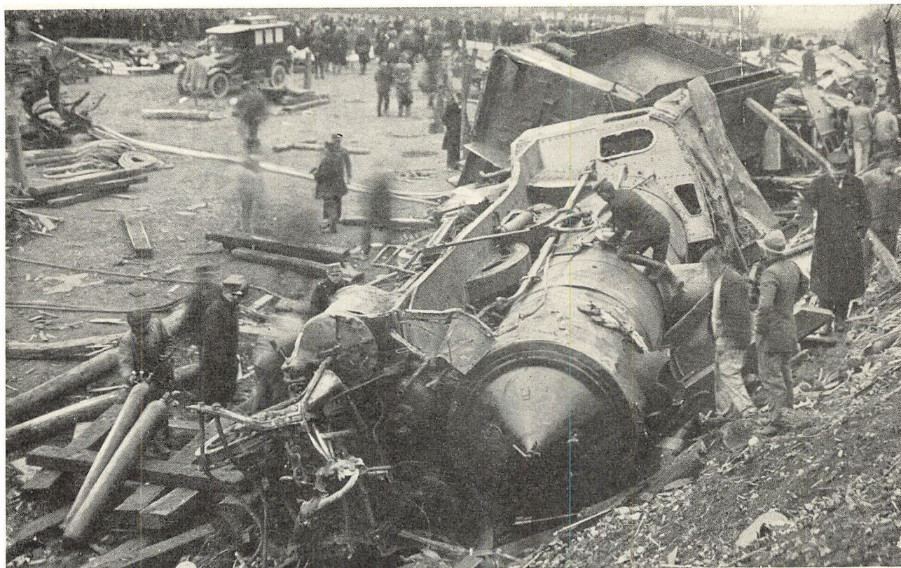
Det bagtra kommende Korsørtogs lokomotiv pløjede sig ind i det holdende Kalundborgtog og styrtede ned ad dæmningen. 5 overfyldte personvogne fra de to tog fulgte efter.
