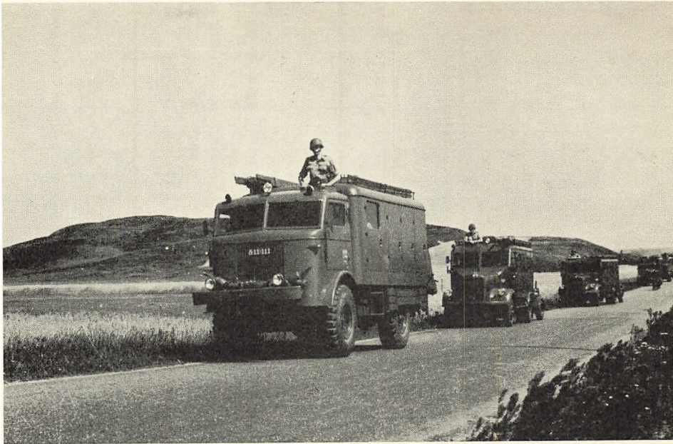
„Branddelingen“, brandkommandoets slukningsenhed, består af 1 automobilsprøjte, 1 brandudrykningsvogn, 1 slangetender og 2 påhængssprøjter.
