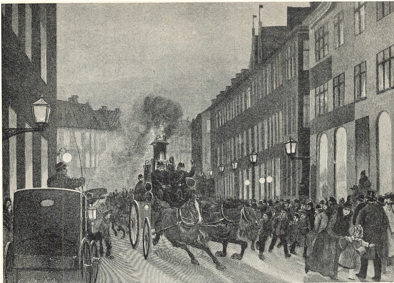
En brand i den indre bys tætbebyggede kvarterer var altid farlig og vakte stor opsigt. Dampsprøjten er blevet tilkaldt og er allerede under opfyring, så gnister og røg vælter ud af skorstenen. Ved nattetid var det et malerisk skue. Træsnit fra ca. 1880.
