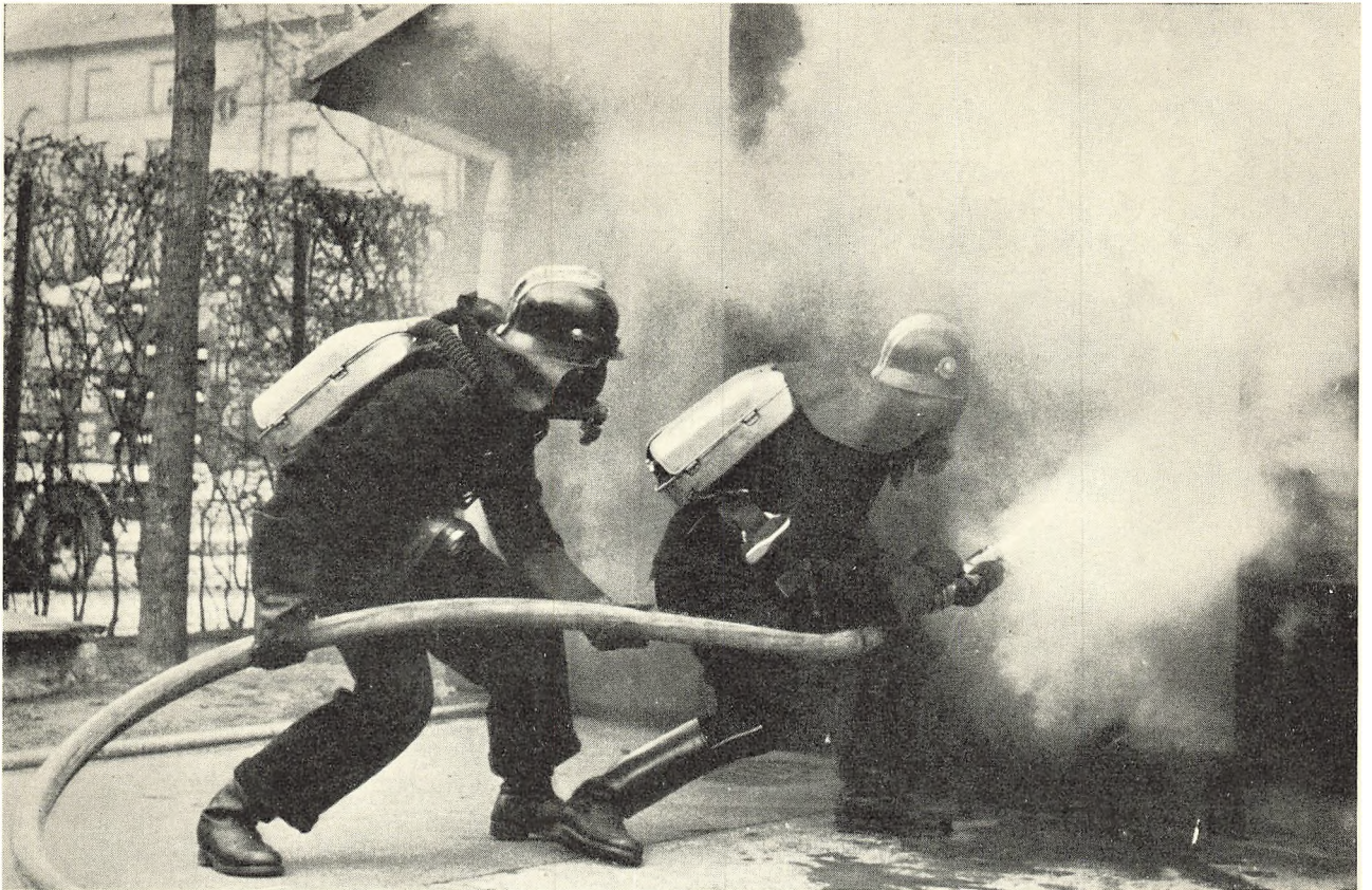
Billedet øverst: Moderne røgdykkere med kredsløbsapparater. I de lukkede aluminiumskasser findes lungesæk og en lille stålflaske med ren ilt. Den udåndede kulsyre optages i en kalipatron. Apparatets anvendelsestid er ca. 1 time.
