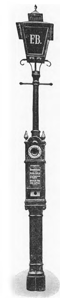
Kombineret brandalarm og gaslygte fra 1891. Karakteristisk for det gamle Frederiksberg.
