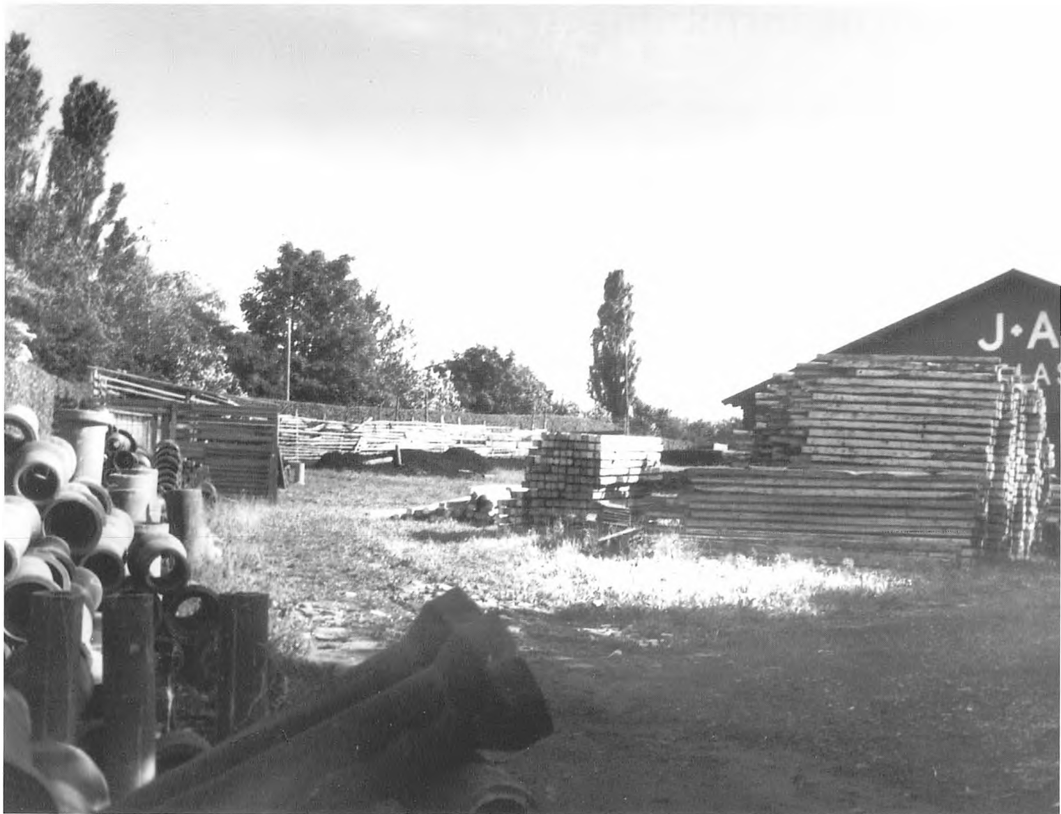
JA's tømmerplads i 1940'erne - i forgrunden cementrør og byggematerialer. (Privateje)
