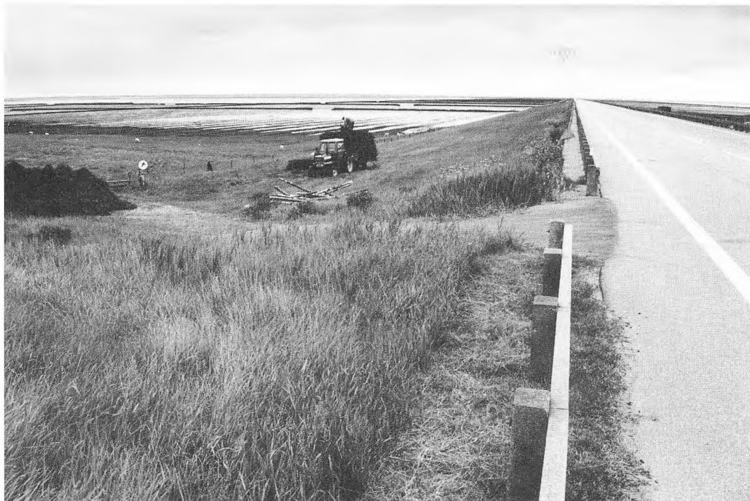
Rømødæmningen hvor den »går i land« på øen ved Nr. Tvismark, tidligere kaldet Padborg.
