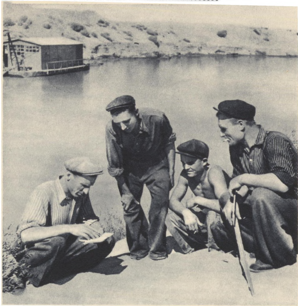
Ingenieur G. Minenko (l i n k s) berechnet die Arbeitsleistung der Arbeiter eines Saugbaggers
