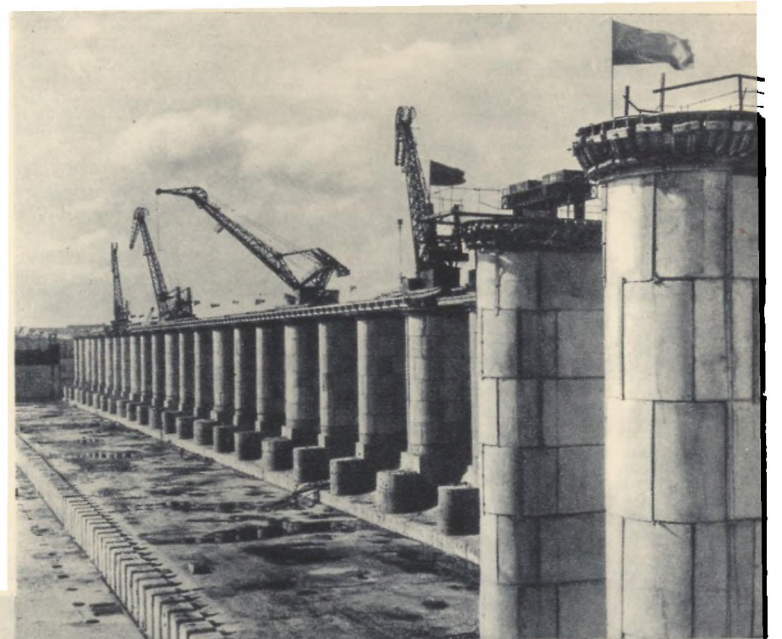
So sah die Überfallmauer eine Stunde vor dem Wassereinlauf in die Baugrube aus →
