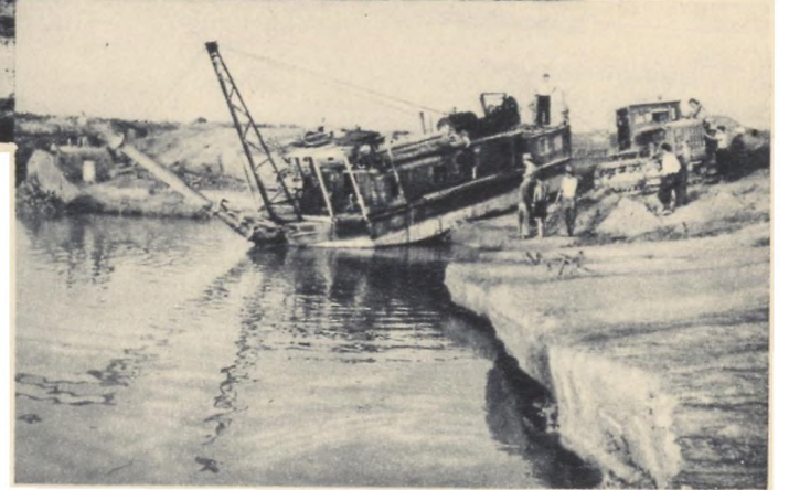
Ein Saugbagger wird auf Kufen an einen neuen Bauabschnitt gebracht
