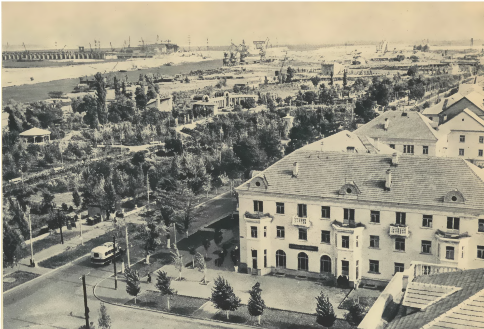
Mit dem Wasserkraftwerk wuchs auch die neue Stadt Nowaja Kachowka heran
