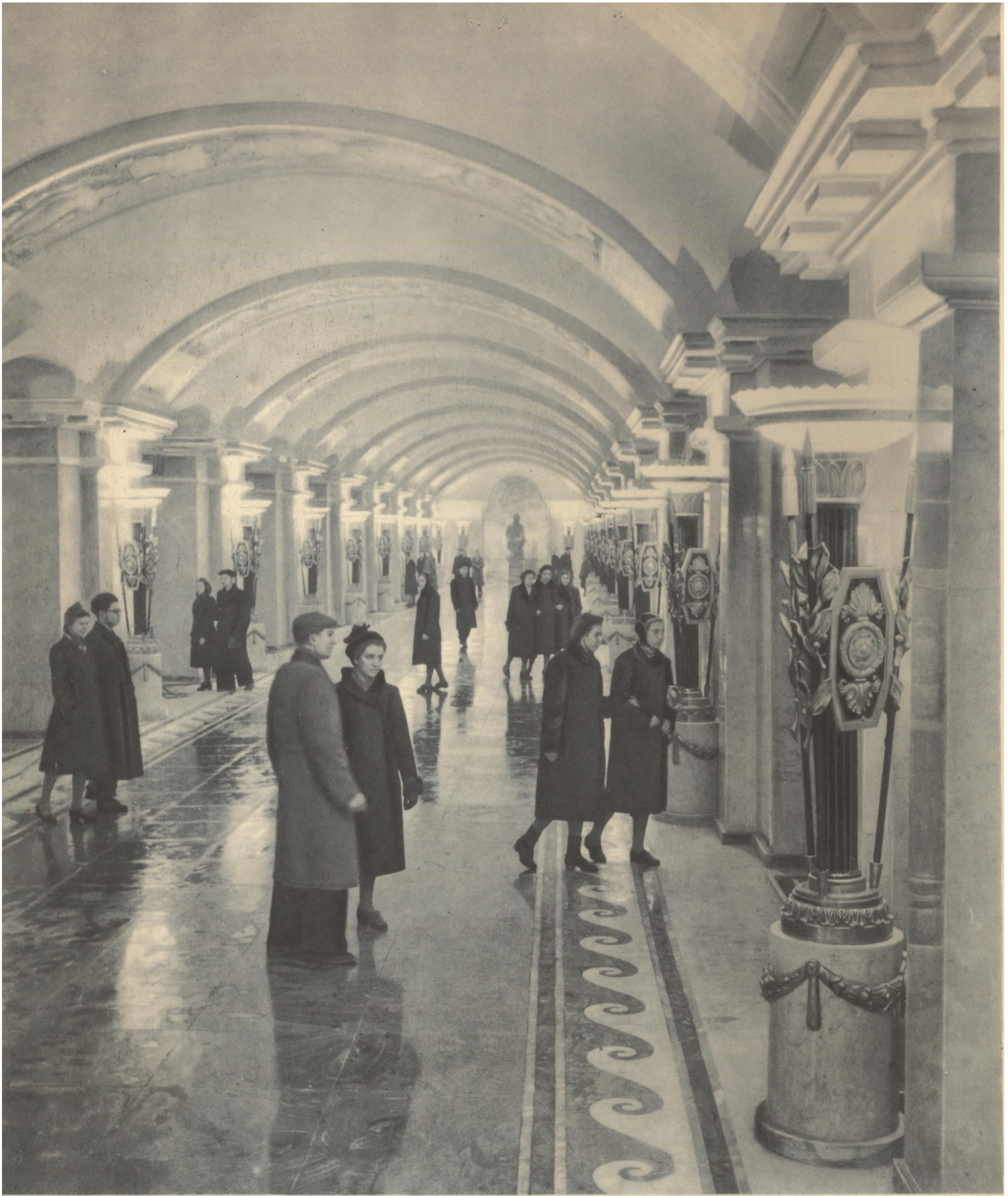
Die erste, etwa elf Kilometer lange Strecke der Leningrader U-Bahn mit ihren acht Bahnhöfen ist fertig. Sie verbindet die wichtigsten Industriebezirke mit dem Stadtzentrum und eine Reihe von Plätzen und Bahnhöfen miteinander. Nach dem Wunsch der Leningrader Werktätigen trägt die neue Untergrundbahn den Namen W. I. Lenin. Unser Bild: Die ersten Fahrgäste sehen sich den U-Bahnhof „Puschkinskaja“ an
