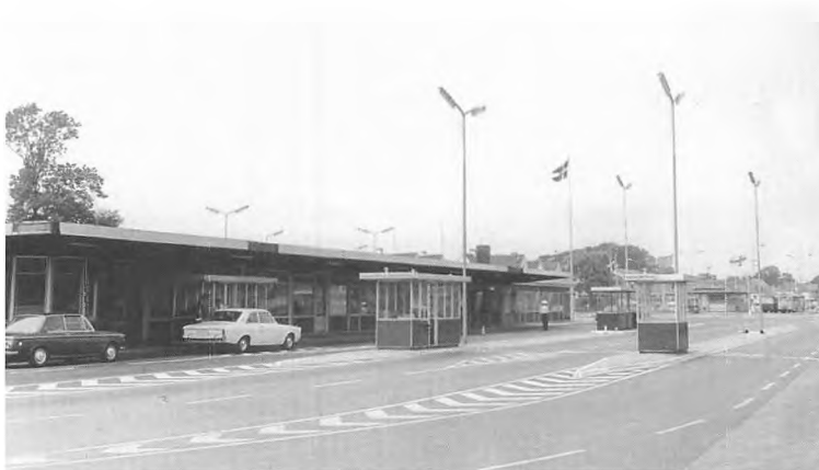
Pas- og toldkontrollen ved Kruså. Efter Danmarks tilslutning til Schengen-samarbejdet i 2001 blev bygningerne nedrevet på den danske og den tyske side af grænsen.
