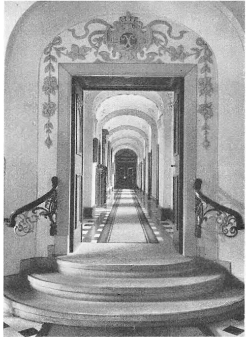
Gangen i Vestre Fløj's Stueetage 1937.
