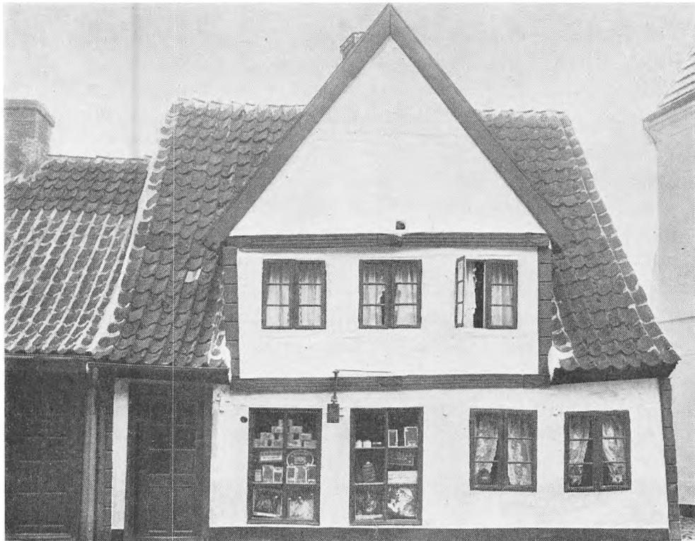
Grundens Upaalidelighed blev ofte Aarsag til, at lige Linier just ikke altid var de gamle Bygningers mest dominerende Træk
