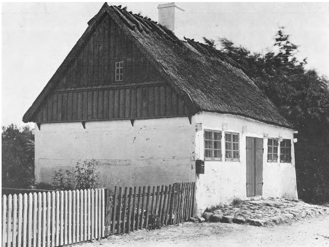
Prins Carls skole i Store Torøje, opført 1719, fotograferet 1921.
