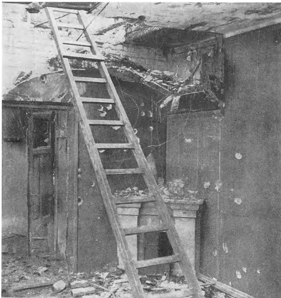
Forstuen i Oberst Paludan-Müllers Bolig. Herfra førte en Trappe op til Loftsetagen. Da Huset skulde gennemsøges efter Branden, anbragte man en Stige i den ødelagte Trappes Sted. Paa Loftet, umiddelbart til højre for Stigens øverste Ende, fandt man Oberstens Lig. I Murcns Puds ser man tydeligt de mange Mærker af Fjendens Projektiler.
