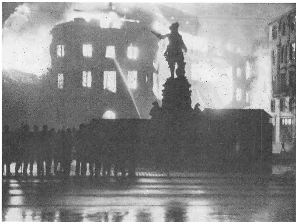
Den 19. December 1944 ødelagde Peter-Gruppen Ø.K.'s Hovedkontor i København. Ved Sprængbomber og Brandvædske blev den monumentale og skønne Bygning tilintetgjort, og Skaden blev løseligt anslaaet til ca. 3 Millioner Kroner.
