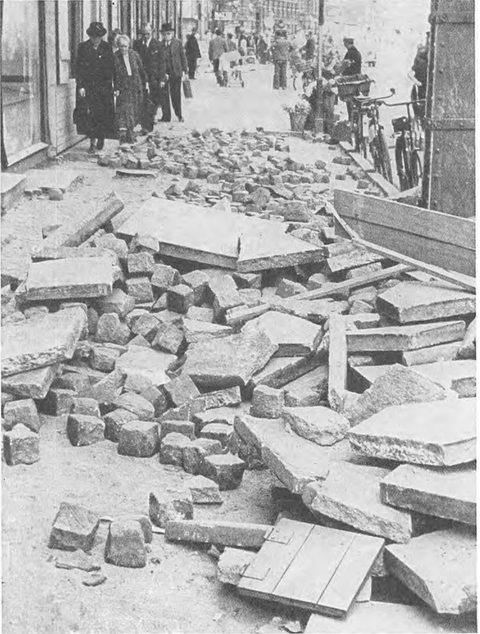
Det er ikke Københavns Magistrat, der er i Færd med at istandsætte en Gade. Det er Byens egne Borgere, som under Folkestrejken har brudt Brolægningen op for at skaffe Materiale til Barrikader.
