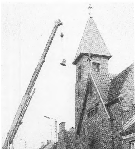
Fig. 5. Kirkeklokken hejses ned fra tårnet for at blive ført til kapellet i Hasle, hvor den igen vil komme til at lyde. (Foto B.M.)
