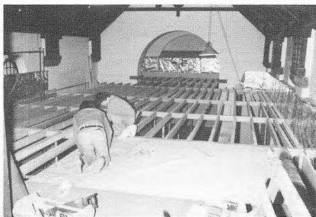
Fig. 4. Bygningen af magasinet i Valgmenighedskirken tager form. Her lægges der gulv, så det store kirkerum deles op i to etager. (Foto B.M.)
