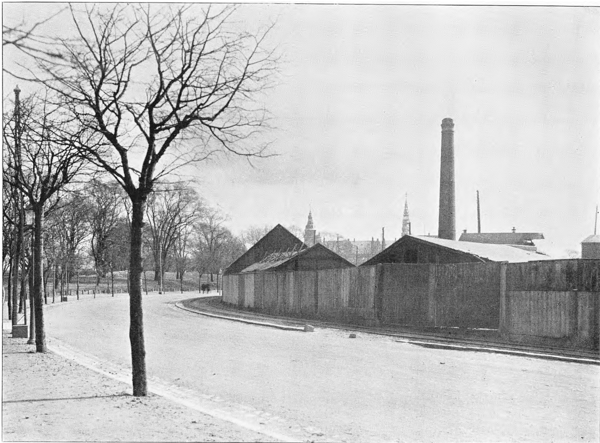
AVENUE FRA BYEN HELSINGØR TIL KRONBORG. ANLAGT EFTER OMHUGNINGEN AF DEN OPRINDELIGE, GAMLE ALLÉ.
