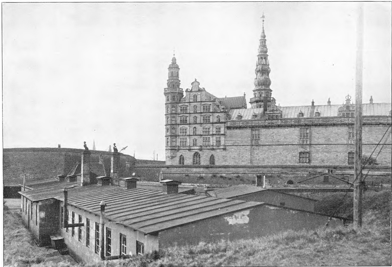
KRONBORG MED OMLIGGENDE VILLAER UD MOD ØRESUND
