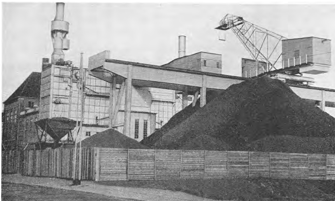
Højspændingsværket i Aabenraa
