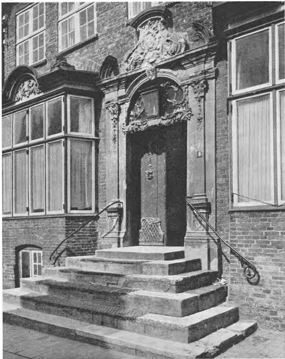
Karnap og Dør i Digegrevens Hus
