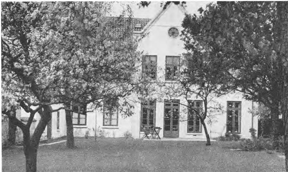
H. P. Hanssens Hus, Nygade, Aabenraa
