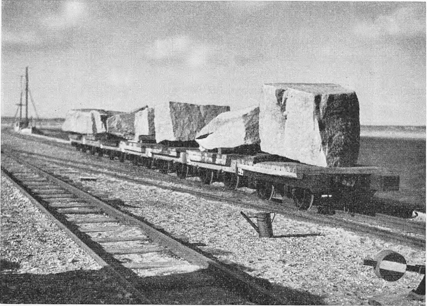
Blokvogne med sten til sikring af Aggertangen.
