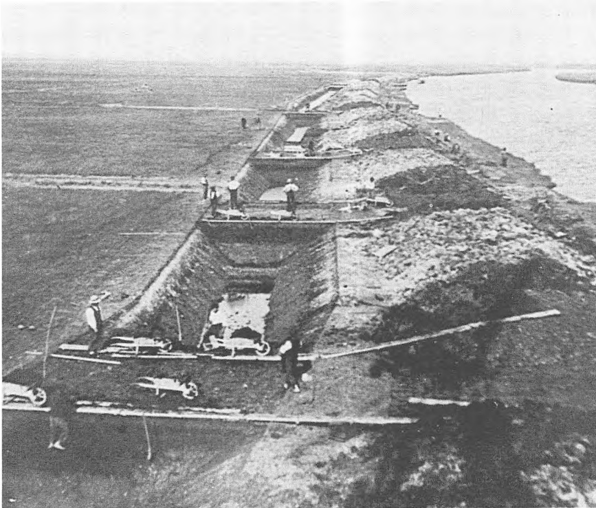
Et dige ved Albæk Enge under opførelse henimod århundredskiftet. Foto: Hedeselskabet.
