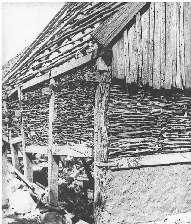
Bindingsværket bestod af lodrette stolper, fodrem og tagrem samt vandrette løsholter. Tavlene ( de enkelte felter) udfyldtes med lodrette kæppe med risfletning, der klinedes med ler. Foto: Frilandsmuseet.
