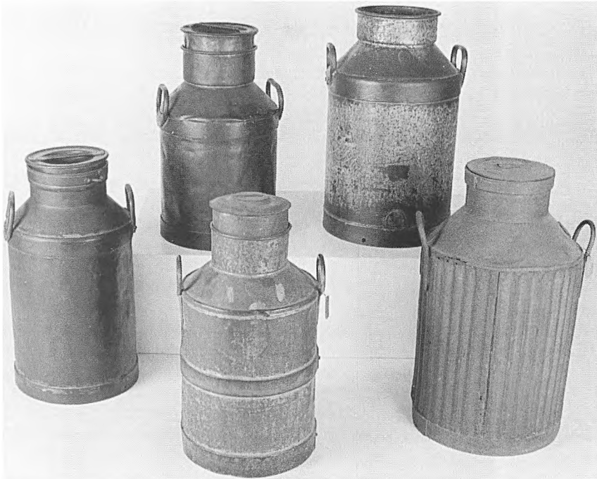
Nogle af de ældre transportspande var lavet af fortinnet stålblek, men efterhånden blev aluminiumsspande almindelige.
