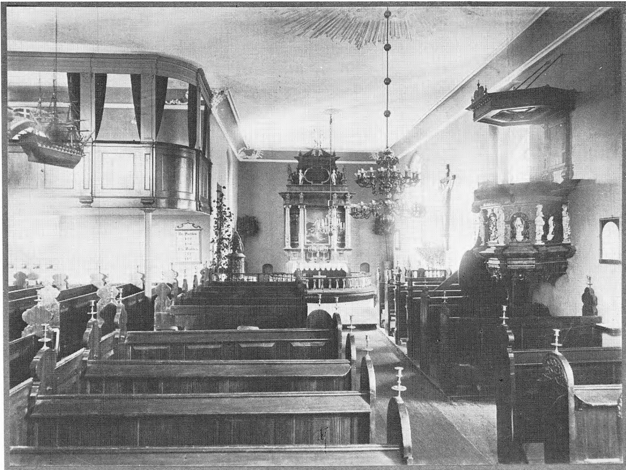
Fra kirkens indre før ændringen 1927 er et enkelt fotografi bevaret. Det er at iagttage i præsteværelset. De ældste nulevende gentoftere vil genkende dette interiør. Kongestolen med de røde gardiner, de gamle bænkerækker og prædikestolens placering lige inden for hovedindgangen.
