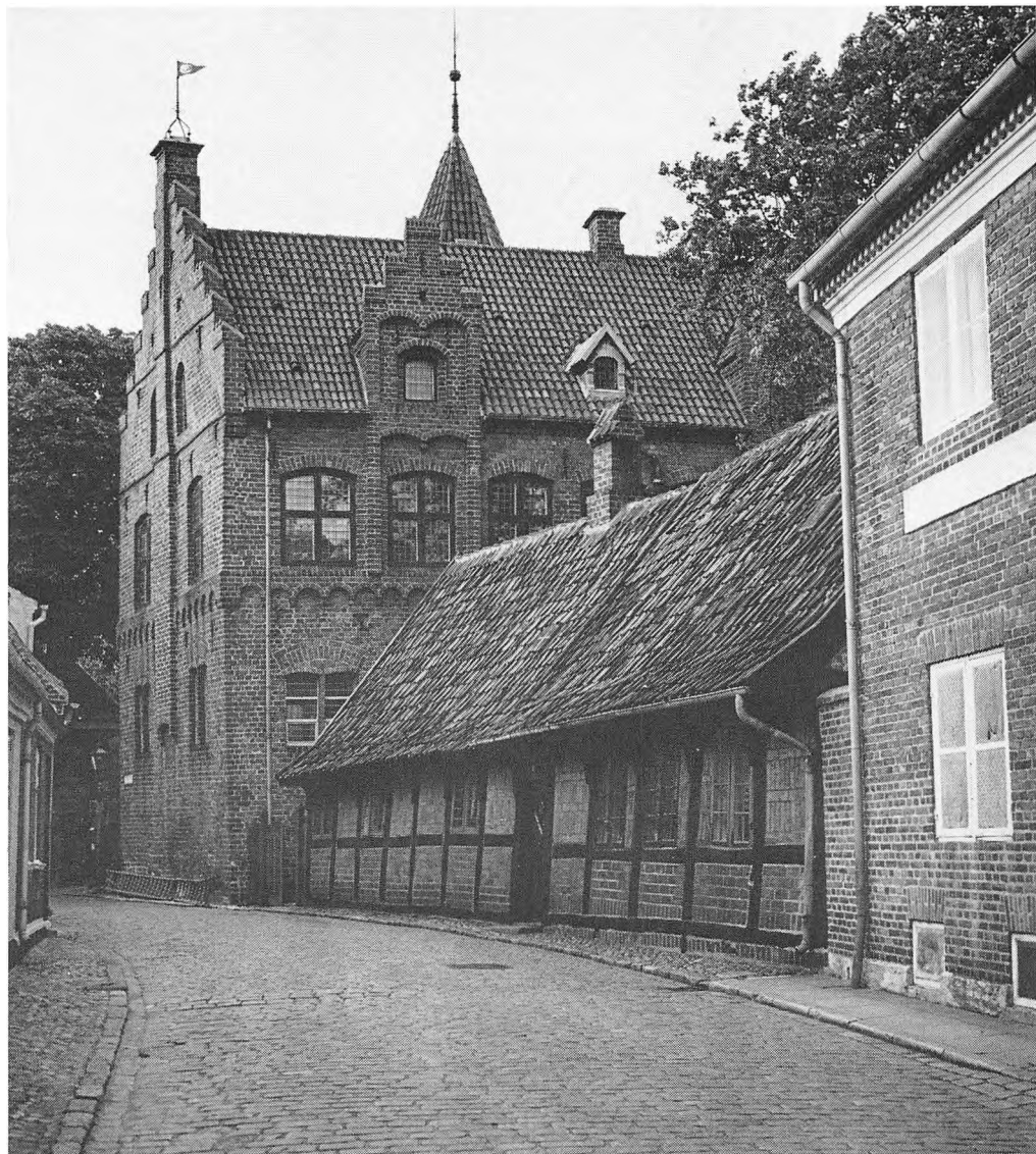
Fig. 5. Bindingsværksboderne i Puggårdsgade.
