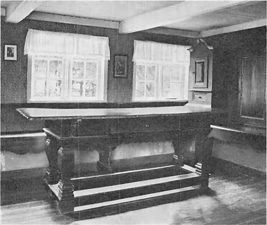
Fig. 7. I dagligstuen er der ved vinduesvæggen den traditionelle opstilling af bord og bæk. Det er en fast opstilling, kendt fra utallige bondehjem. Også i bogstavelig forstand fast, for bænken kan ikke flyttes, men er sammenhørende med det lave rygpanel under vinduerne og det høje bordende-panel på den korte tværvæg mellem vindue og dør ved enden af bordet. I hjørnet ved siden af husfaderens plads for bordenden er hjørneskabet anbragt oven på bænken.
