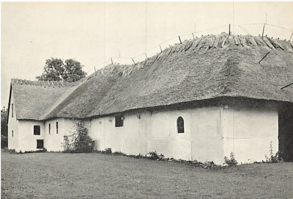
Fig. 9. Nordlængen viser forskellige stadier i gårdens bygningshistorie. Den smalste del af længen er opført i den gamle bindingsværkskonstruktion med bjælker, der er tappet gennem stolperne, og hvis tappe stikker frem på ydersiden. I det nærmeste hjørne er en vognport, men ellers optages hovedparten af længen af et laderum. Bag dette er længen gjort bredere under anvendelse af den yngre bindingsværkskonstruktion med bjælker, der lægges oven på murremmen (og folgelig ikke kan ses på billedet). Det er kostalden, man har haft brug for at udvide på denne måde. Det er også kostalden, der er blevet begunstiget ved opførelsen af den endnu senere grundmurede gavlende, der stikker uden for gårdfirkanten, og som er den yderste ende af den i sin helhed grundmurede ostlænge.
