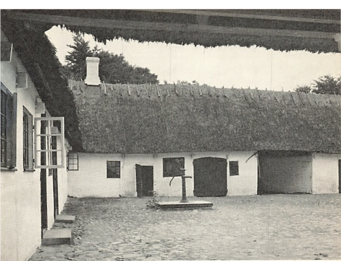
Fig. 1. Når man kommer til museumsgården, går man først gennem porten ind på gårdspladsen. Den er omsluttet af gårdens fire helt sammenbyggede længer. Til venstre har man stuehuset, og ligefor er vestlængen med dør til bryggerstet, vognport og bagport, der fører ud til hæsschaven. Overalt er der hvidkalket, og man ser enderne af bjælkerne stikke frem med regelmæssig afstand, hvor de er tappet gennem stolperne.
