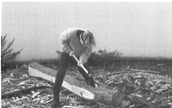
Arbejdet påbegyndes. Det store tømmer tilhugges i museets gård.
