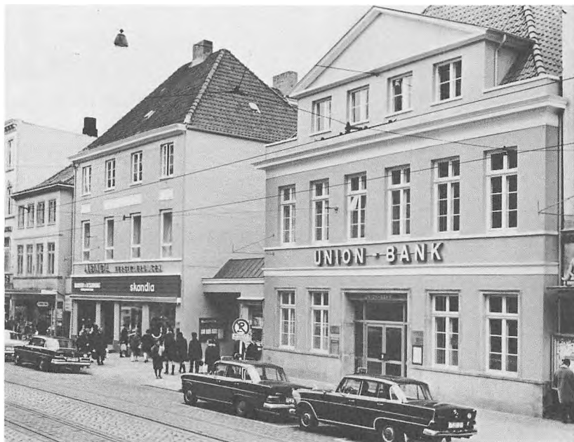
Efter ombygningen i 1968
