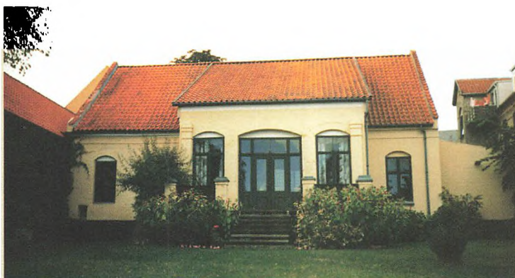
Havehuset har været fredet.
