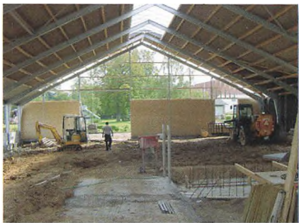
Der har været fart på byggeriet her i efteråret
