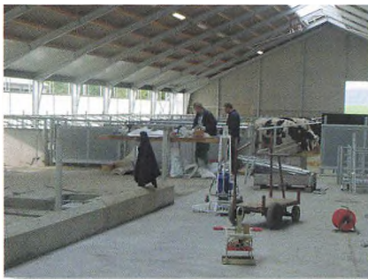
Håndværkerne er ved at lægge sidste hånd på ungdomstalden
