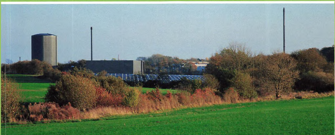
▲ Skolens omgivelser viser også samfundets forandringer. En af skolens naboer er Gråsten Fjernvarme med solceller, halmfyringsanlæg og varmtvandsbeholder.
